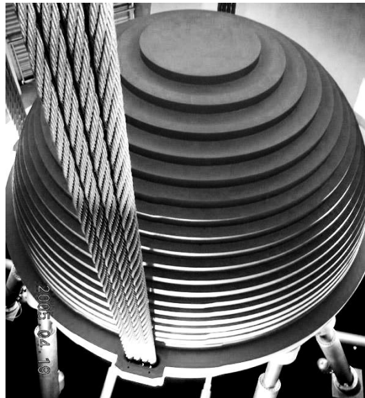
Figuur 3.1: Bolvormige TMD in het Taipei 101 gebouw (Taiwan) [16]
