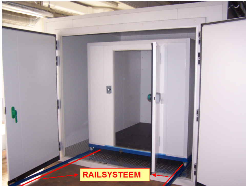
Figuur 3.2: De testkamer in opbouw met het railsysteem.
