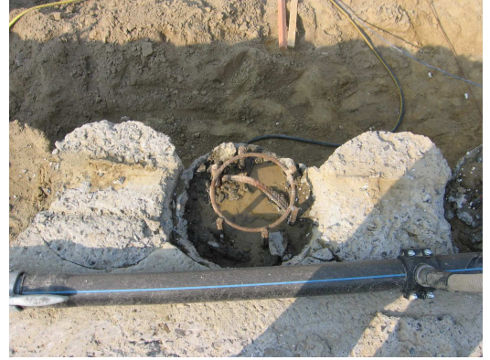
Foto 1-3: Korf in afgewerkte wand
