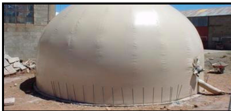
3. Blaas de ballon op met een ventilator
