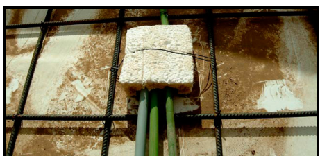
7. Bevestig de leidingen over het betonijzer
