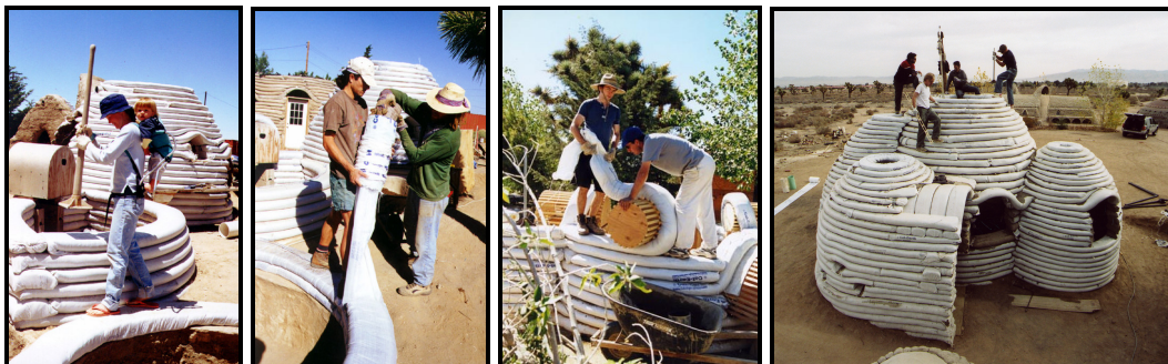
Figuur 3.6: Constructiewijze Sandbag Shelter
