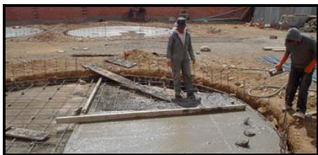
1. Stort een betonnen fundament
