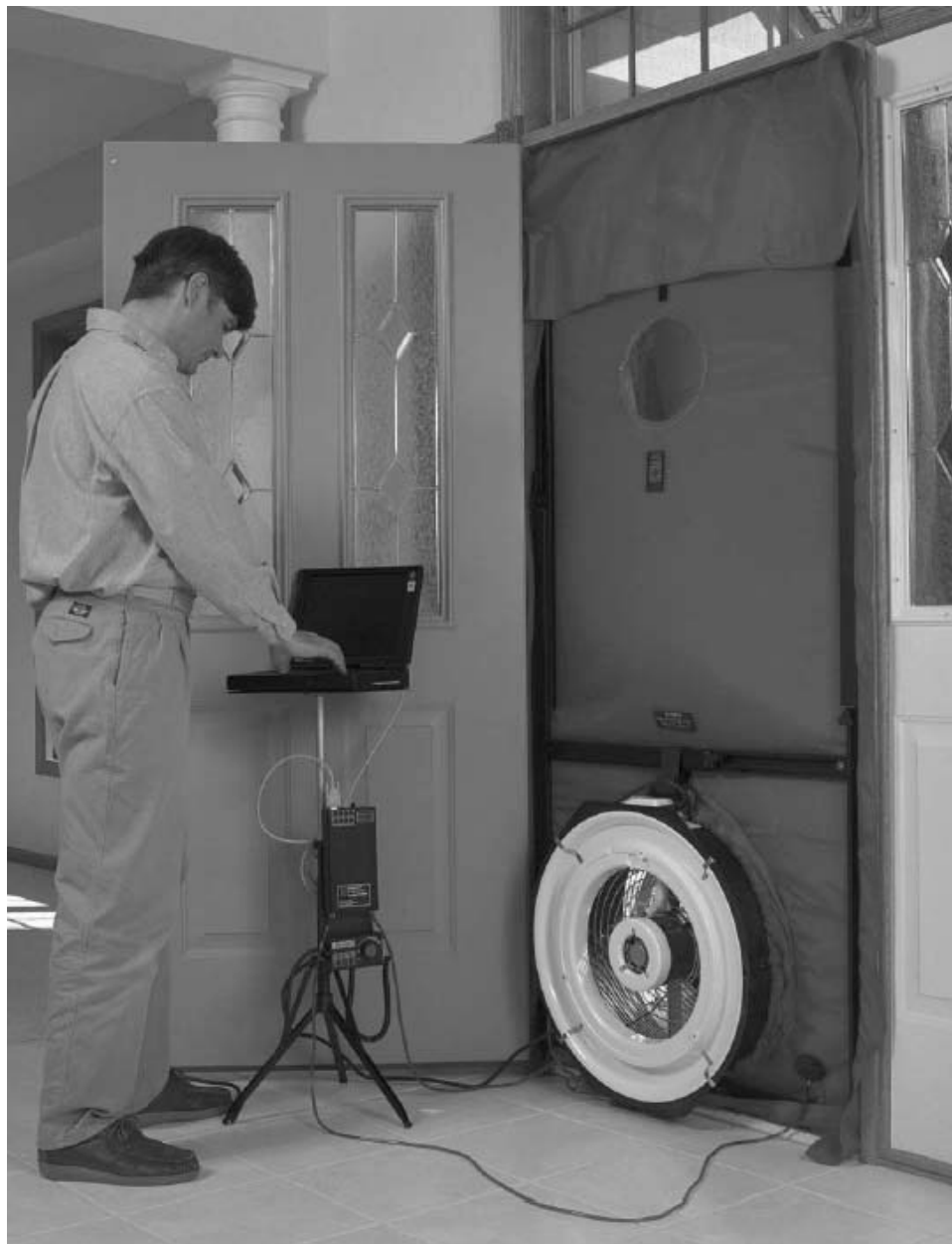
Figuur 1. “Opstelling blowerdoor”
