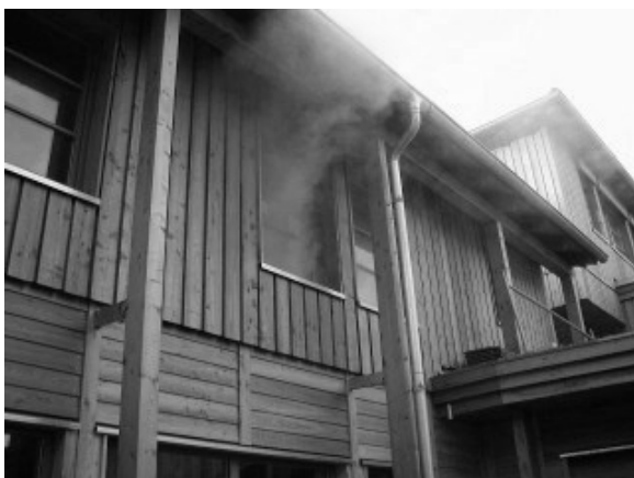
Figuur 60. “rook in overdruk schrijnwerk” Figuur 61. “rook in overdruk dakrand”
