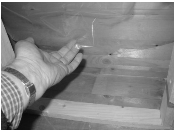
Figuur 57. “manueel lekken opsporen”
