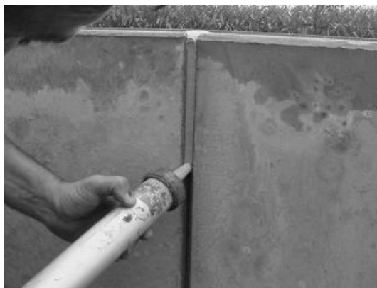
Figuur 120. “afkitten prefabelementen”
