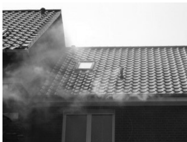
Figuur 60. “rook in overdruk schrijnwerk” Figuur 61. “rook in overdruk dakrand”
