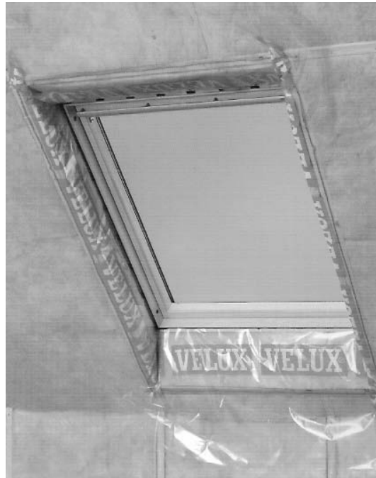
Figuur 137. “aansluitingsscherm dakraam VELUX” [106]
