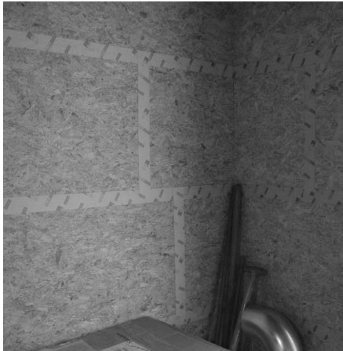
Figuur 114. “OSB-platen als luchtdichte afwerking in passiefwoningen”
