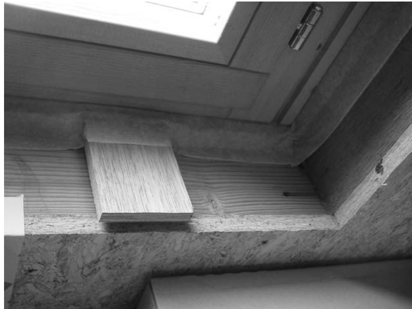
Figuur 133. “raam met luchtscherm bevestigd tijdens fabricage”
