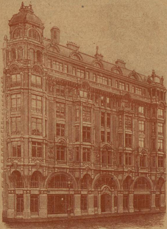
Immeubles du Bureau technique central.
