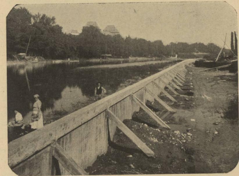
Mur de soutènement au long du Pô (Italie), entièrement en béton armé
