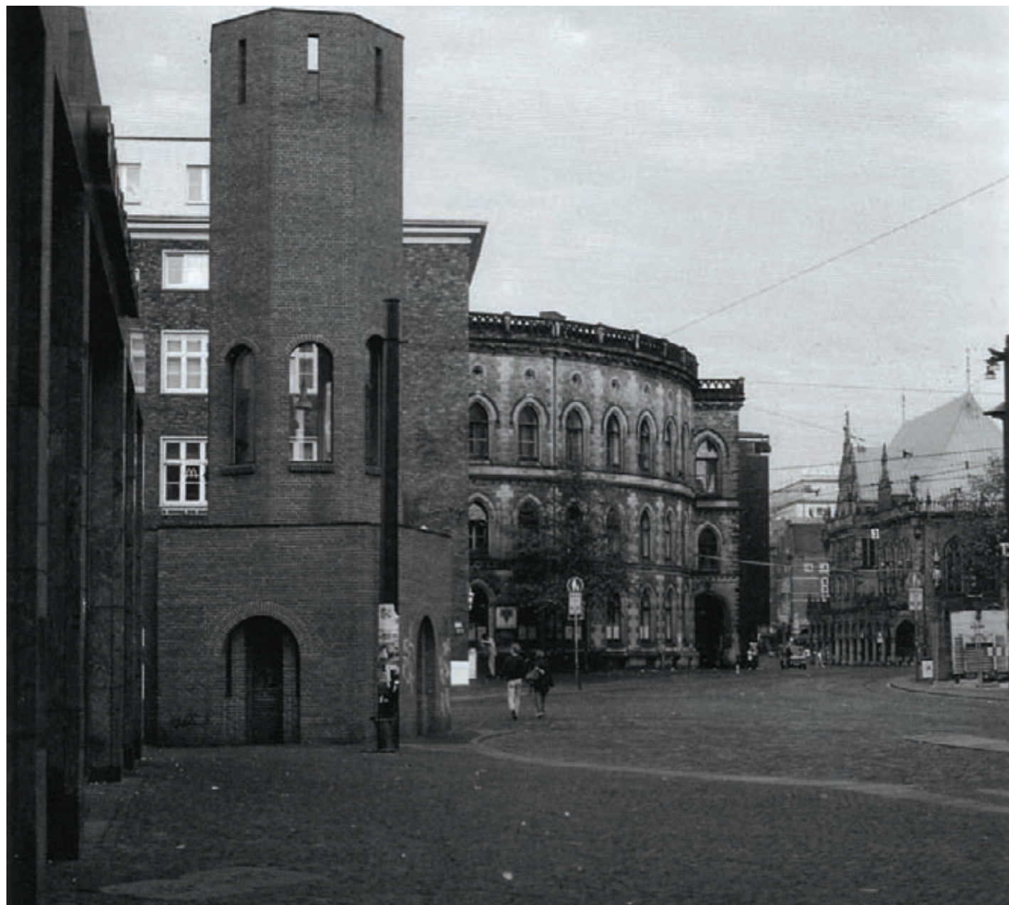
Per Kirkerby controletoren voor de openbaarvervoers- maatschappij, 1988, Bremen
