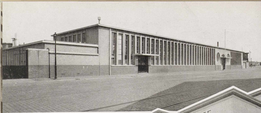
Postes et Télégraphes, garage et ateliers, La Haye. Sous-toiture.
