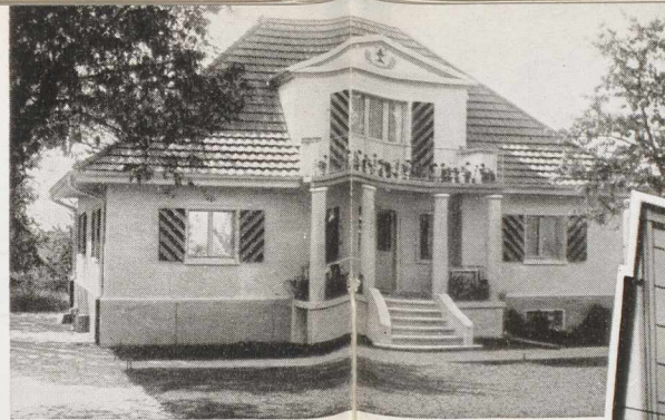
Villa, Arlesheim. Sous-parquets et sous-toitures.
