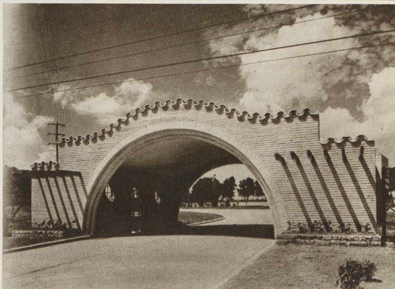
Cité de l'Enfance. Le pont de protection sous les câbles du transport houiller qui surplombe la cité. Il s'agit d'une servitude imposée par la proximité d'un charbonnage.
