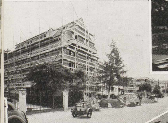
Immeuble de rapport, Zurich. Isolation de toiture.
