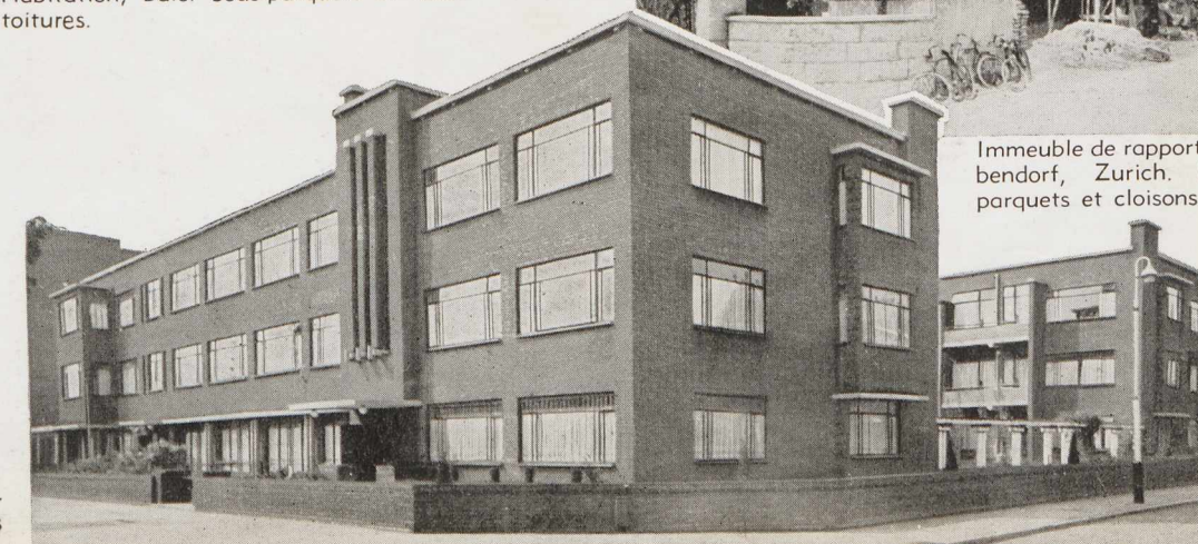
Immeuble à appartements, La Haye. Isolation des hourdis et revêtement des murs extérieurs.
