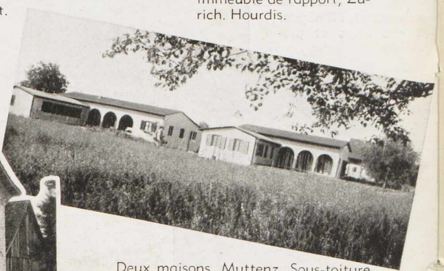
Deux maisons, MuttENZ. Sous-toiture.
