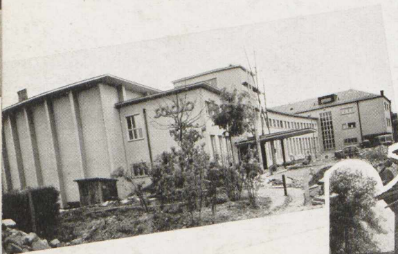
Institut de la radio, Zurich. Isolation de terrasses.
