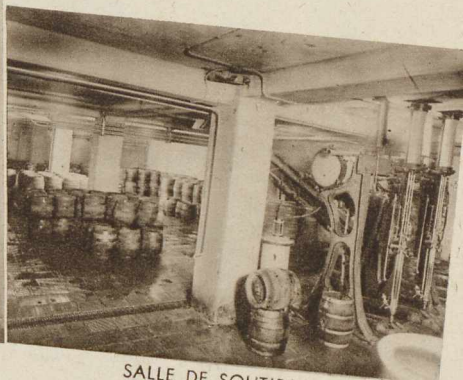
SALLE DE SOUTIRAGE.
