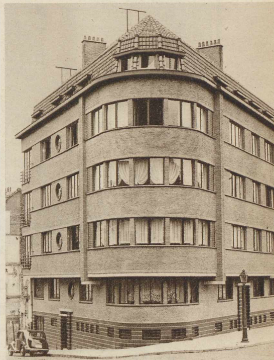
Immeuble de rapport, à Bruxelles. Arch. Lauweryns, Ostende. Parement en briques de Dieren vieil or, format romain, fournies par Kessels.
