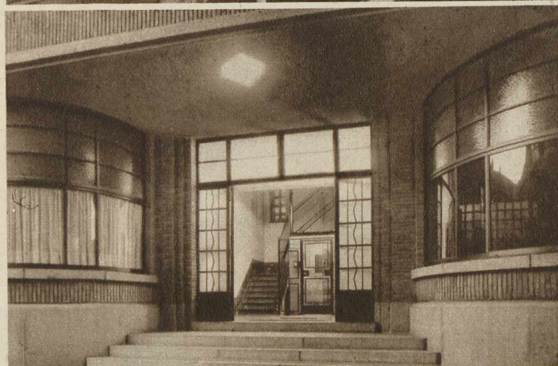
L'entrée principale de l'aile des services administratifs. A droite, la salle du Conseil, à gauche, le quartier des bureaux. (Photo R. Cuyllits.) Tous les travaux de carrelages ont été exécutés par la firme Vve Armand Pire & Fils, 67, rue Robert Fesler, Marchienne-au-Pont. Tous les revêtements en faïence et céramique proviennent de la S. A. Cérabel, de Pavillons-Florennes; les pavements en flammé jaune et noir, de la S. A. des Carrelages du Centre, à La Louvière. Le hall de la brasserie a été pavé en Asphalt-Blocks, de la Sté Ame Asphalt-Block-Pavement, à Lessines.
