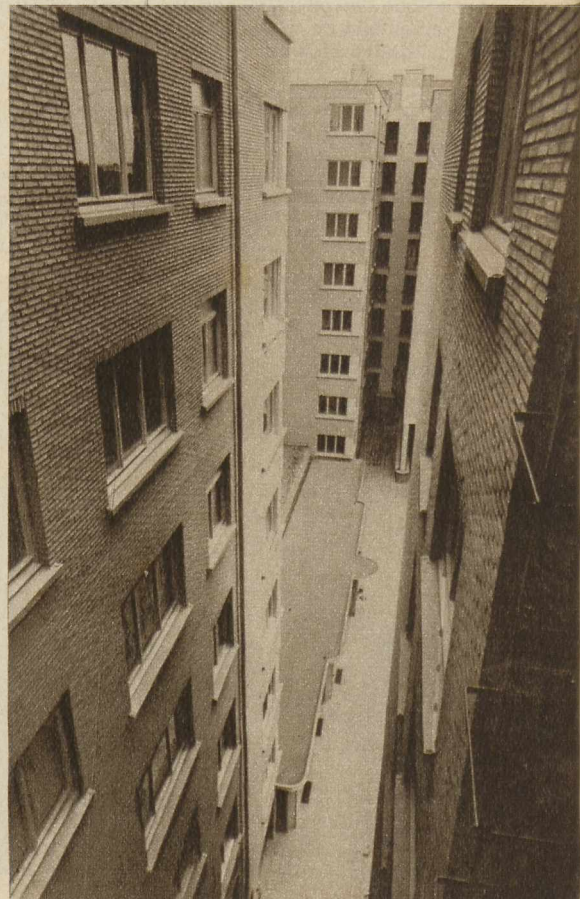
Les deux blocs, la cour et le bâtiment des garages. Archit. Victor Gorlé. (Photo 't Felt.) Les quatre ascenseurs pour locataires et les deux ascenseurs de service ont été construits et installés par la Société Anonyme « Ascenseurs E. Thiery », 25, rue de la Violette, Anvers.
