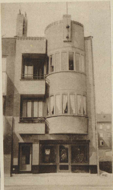
Petit immeuble de rapport, à Ganshoren. Arch. G. Michel. Les briques de façade sont du type Fleur de Pommier C sablé 21 x 4 cm. « Vilvordit ». Les couvertures en asphalte ont été exécutées par la firme Asphaltage — couverture et travaux — directeur M. Ch. Schreiden, 17, rue de l'Intendant, Bruxelles, tél. 26.83.39.
