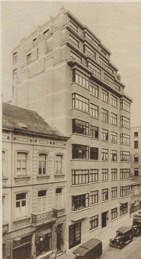
Ci-contre : Immeuble de rapport, à Ixelles. Arch. Blémont. Parement en briques de Venloo C. H. V. jaunes, format romain, fournies par Kessels.
