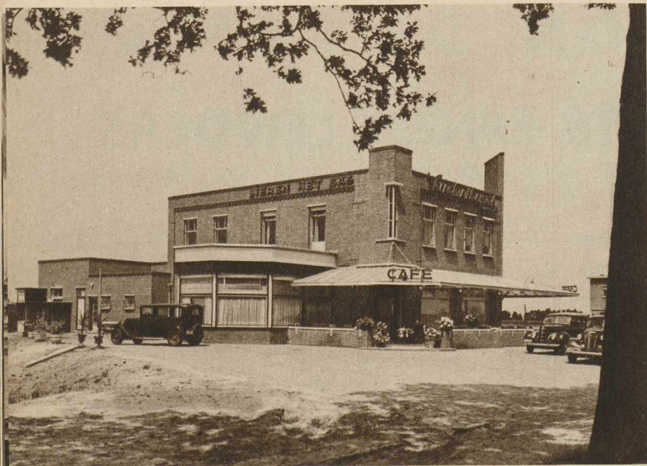
Vue extérieure. Arch. Schets. (Photo Hoelen, à Capellen.)
