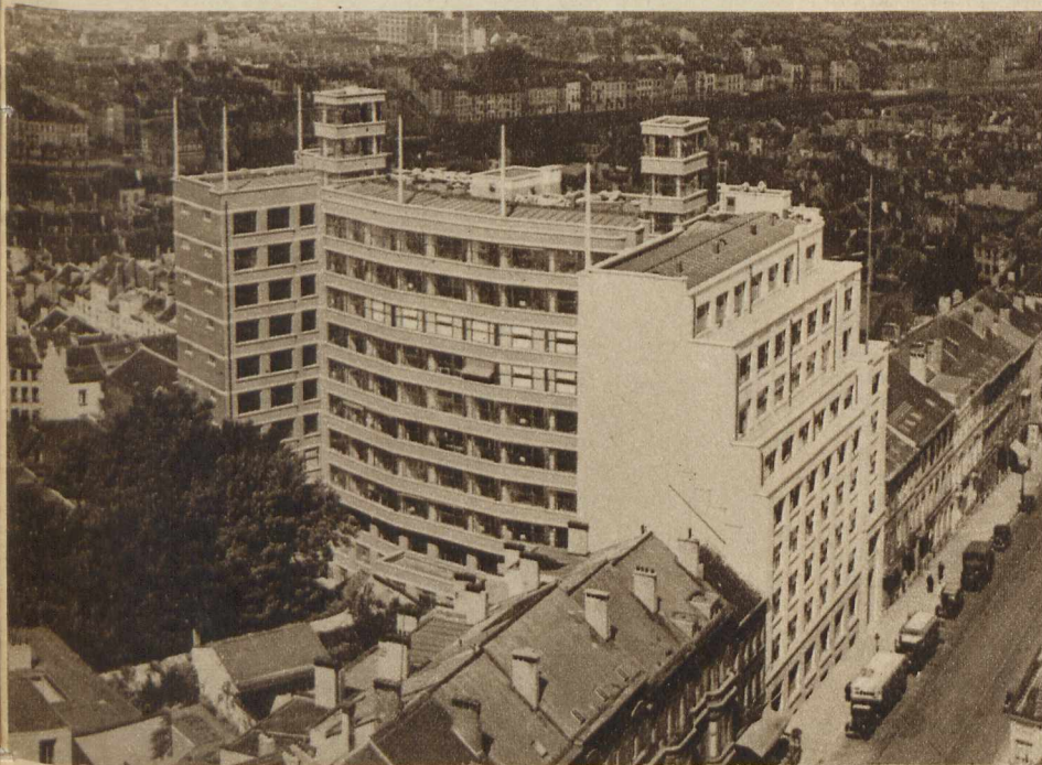
← Vue d'ensemble du nouvel Hôtel de la Régie des Télégraphes et Téléphones. De droite à gauche, les bâtiments A (sur rue), B (central), C (petite aile). A l'intersection des ailes, les tours d'expérience. Sur les toitures, les mâts de 10 m. de hauteur qui portent les antennes. Arch. Michel Polak. Entrepreneur René Gillion. (Photo Sergysels.)
