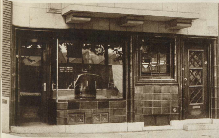
Devanture de magasin, à Gand. Arch. Merlé. Cadres profilés et dalles de grand format en grès noir métallique, façade en pierres de France. Ces céramiques sont fabriquées par la maison Helman, à Berchem-Bruxelles.
