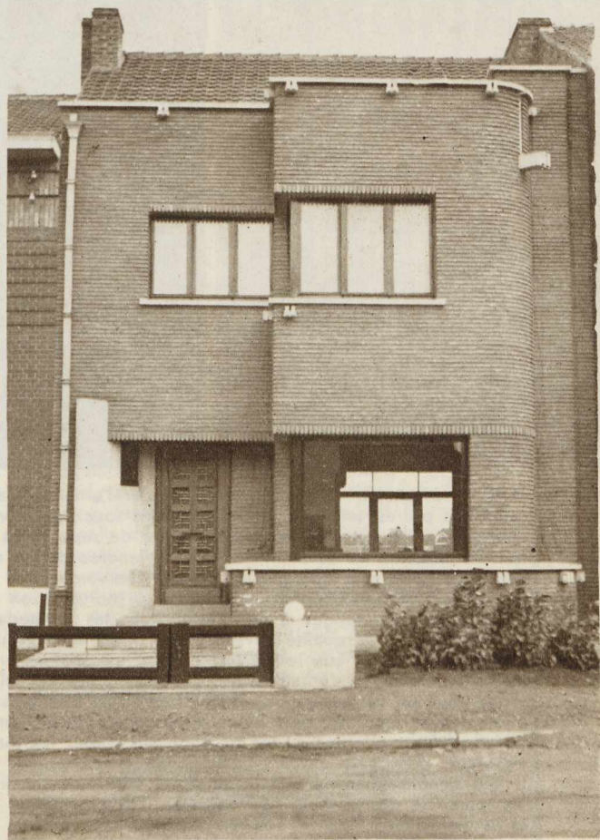
Maison d'habitation moderne, à Mons. Arch. René Poëis, 5, rue de Naast, Mons. Façade en briques de Dieren jaune vieil or.
