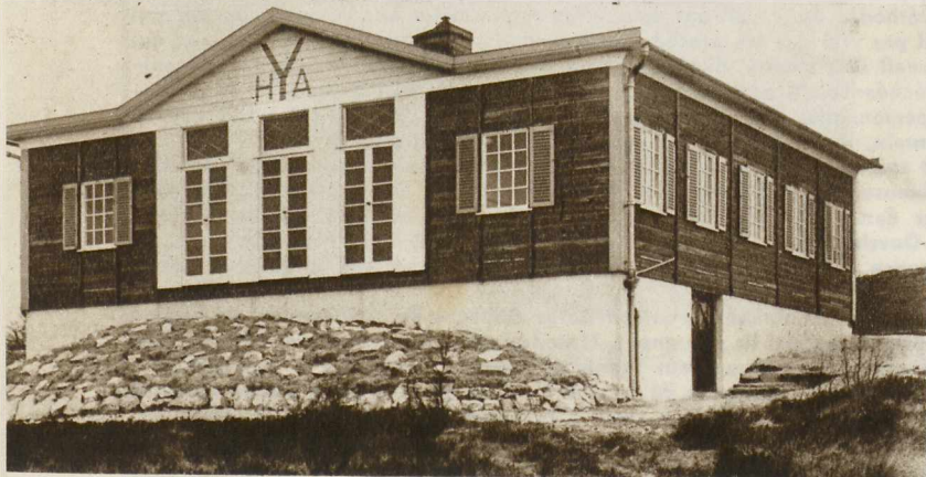
Auberge de jeunesse dans le nord du pays de Galles. Chaque fenêtre éclaire un petit dortoir de six lits, trois lits superposés à droite et trois lits superposés à gauche. La partie centrale du bâtiment est réservée aux locaux de vie commune et au logis des parents aubergistes.
