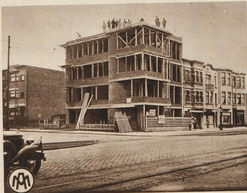
Immeuble de rapport, avenue de Gitschotel, à Anvers. Ossature en béton armé et dalles en béton, armées de plaques « AM'ACIER ». Architecte De Meyer. Bureau d'études Lauwers, Ingénieur.
