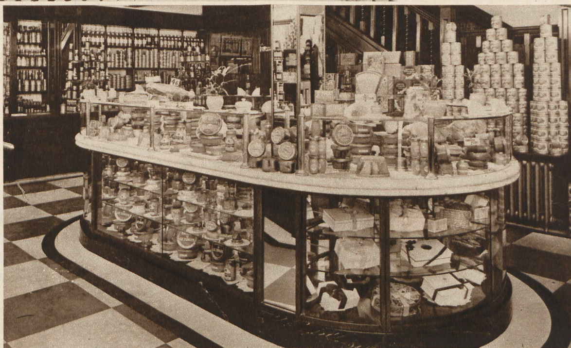
Comptoir pour l'épicerie « Standing Ltd », Harrogate. Toute sa surface est utilisée pour l'exposition des comestibles. Des glaces coulissantes permettent d'accéder sans difficultés aux produits disposés dans sa partie inférieure. Construction Etablissements Fred Sage, à Londres.
