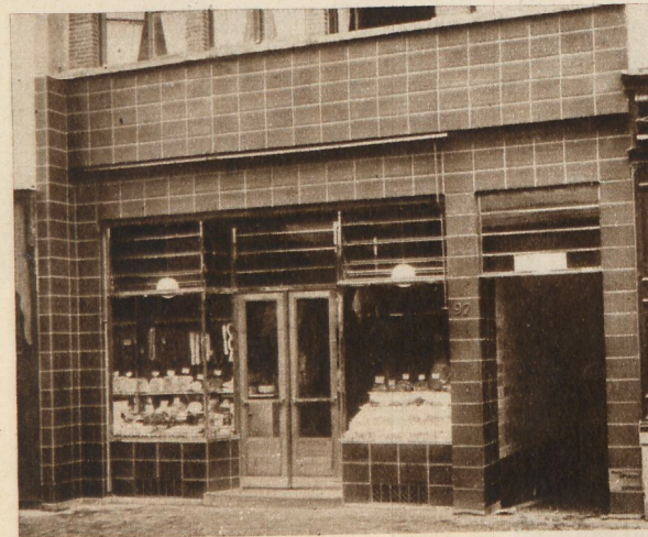
Les quartiers populaires aussi se modernisent. Voici une boucherie de la rue Haute, à Bruxelles, dont le revêtement en larges carreaux céramiques d'un bel émail rouge orangé, fut fourni par la firme Claes, 12, rue du Croissant, à Forest. De même que les briques « Fulva », ton fauve, de la partie supérieure de la façade.
