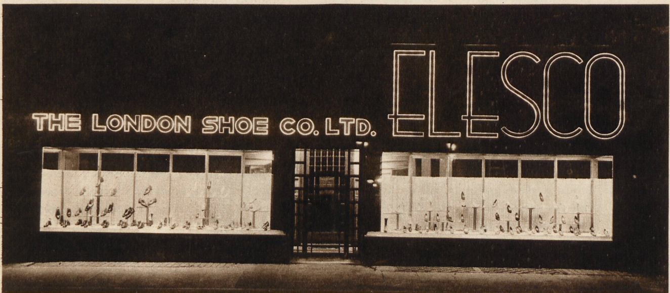
MAGASIN DE CHAUSSURES, A LONDRES. A REMARQUER L'AGREMENT DES PROPORTIONS ET L'ELEGANTE NETTETE DE LA PARTIE PUBLICITAIRE. ARCH. H. TANNER, SIDNEY JAQUES, F. & A. RIBA.
