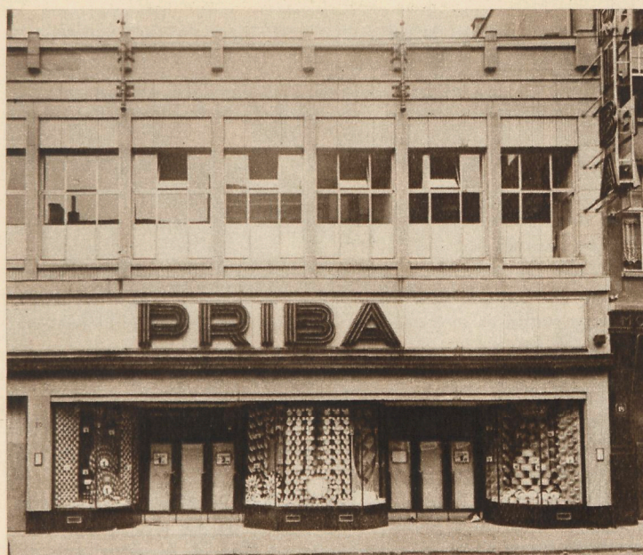
Le magasin « PRIBA » à Anvers. Arch. Dautzenberg. La disposition des portes permettant l'entrée ou la sortie simultanée de 6 personnes, celle des vitrines d'exposition où l'on voit réalisés d'efficaces étalages « de quantité » ainsi que la composition à la fois sobre et publicitaire de la façade servent fort bien les intentions de ce type d'entreprise. (Photo Bossut, Hoboken.)
