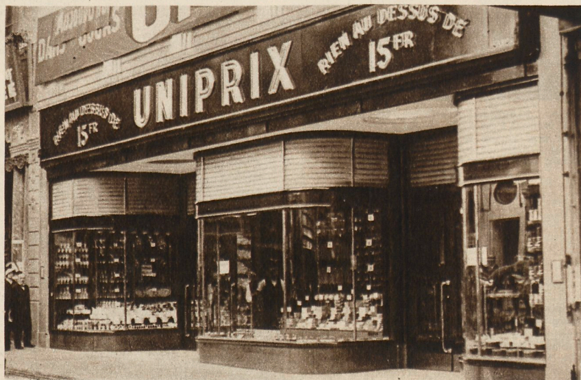
Le magasin « UNIPRIX », de la rue Neuve, à Bruxelles. C'est la COMPAGNIE BELGE DES ASCENSEURS OTIS qui a installé l'escalier roulant et tous les appareils de levage, tant aux magasins de la rue Neuve qu'aux Halles Centrales, à Bruxelles, et aux Magasins d'Anvers.
