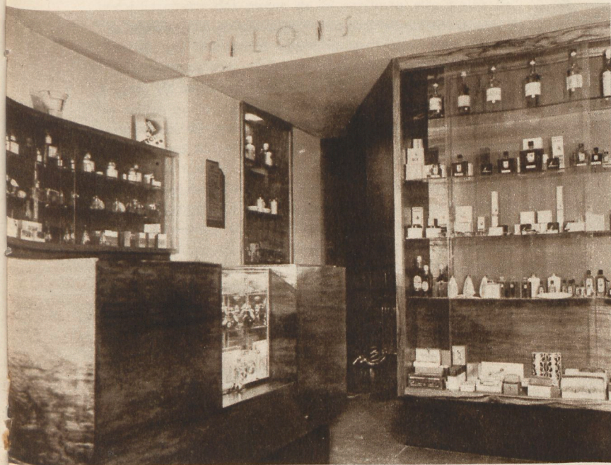
Intérieur du magasin ANTOINE, rue de Namur, Arch. Marcel Callie. La caisse elle-même renferme une vitrine éclairée. Remarquons-le à nouveau, l'art et la logique publicitaire se fondent dans toute réalisation de qualité. (Photo Van Hecke, Bruxelles.)
