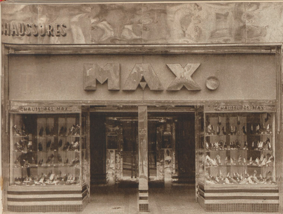
La boutique du chausseur MAX, à Bruxelles, constitue un typique exemple des possibilités décoratives du revêtement d'acier inoxydable. (Studio « Bâtir » — Photo Hayois.)
