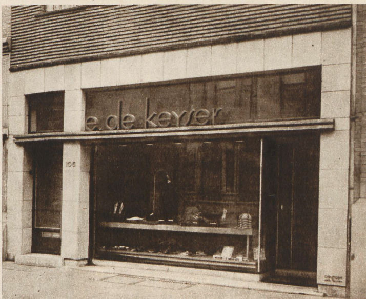
Magasin de nouveautés pour Messieurs, à Louvain. Arch. C. Reynaert. La partie architecturale est constituée par de beaux carreaux de terra cotta non émaillée, de ton beige. Le linteau est également en terra cotta, de ton brun. Le tout est fourni par la firme Claes, 12, rue du Croissant, à Bruxelles. (Photo Mansy, Bruxelles.)
