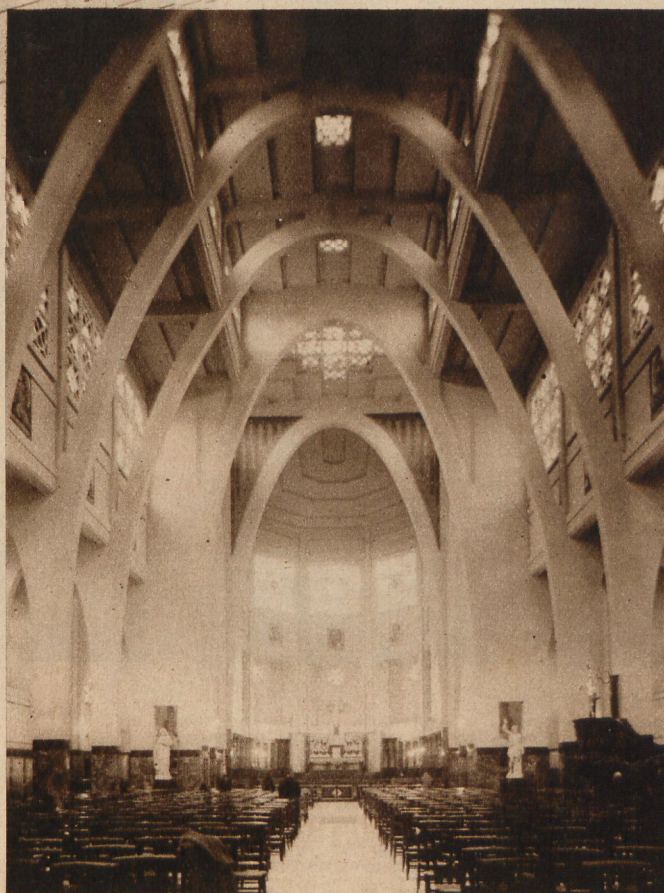
Eglise Saint-Jean-Baptiste. Architecte J. Diogre. L'ampleur de la nef principale est soulignée par le rétrécissement des nefs latérales, qui ne constituent plus que des déambulatoires. Des arcs en béton, de forme parabolique, dans lesquels s'insèrent les parois éclairantes disposées en encorbellements successifs et que relie des plafonds horizontaux à nervures apparentes forment la voûte.
