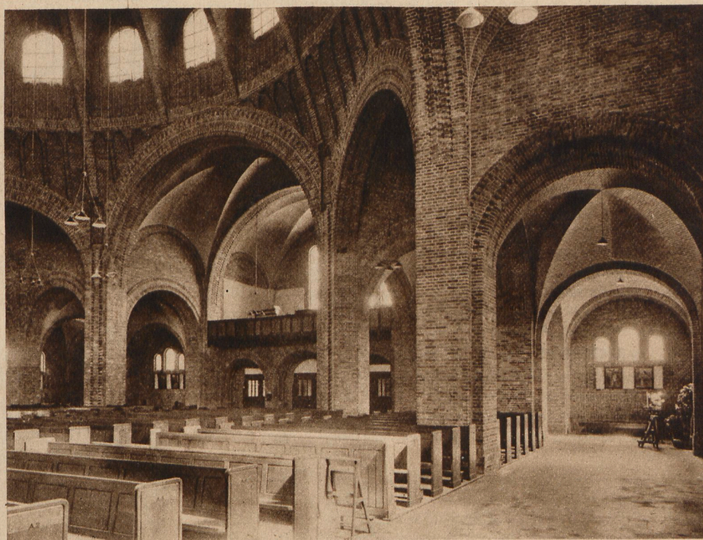
UNE VUE DE LA GRANDE NEF DE L'EGLISE NOTRE-DAME DE BON SECOURS, A BUSSUM, CONSTRUITE EN BRIQUES DE DIJEN.
