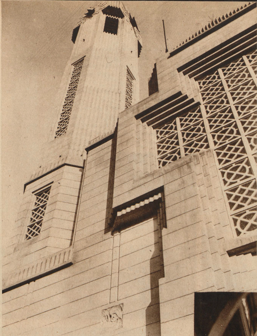
Effet de perspective de la façade de l'église Saint-Jean-Baptiste, à Molenbeek. Architecte J. Diogre. Un parement en pierre régionale, sur ossature en ciment armé donne de la luminosité à ce temple. Le plan constitue un heureux compromis entre le plan de la basilique latine et celui de la cathédrale. (Photo W. Kessels, Bruxelles.)
