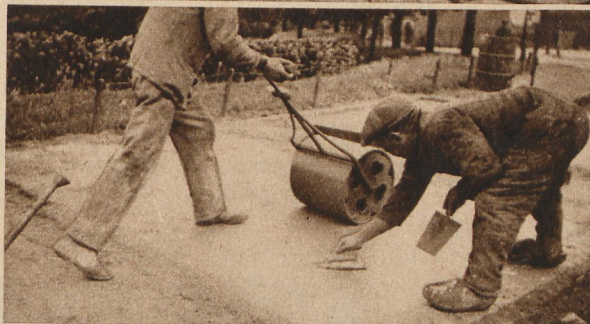
ETABLISSEMENT D'UN TROTTOIR EN BETON ASPHALTIQUE PAR L'EMPLOI D'EMULSION SPECIALE (TROTTOIR A SCHAER- BEEK).
