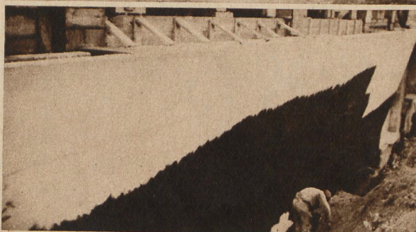
ENDUISAGE AU « MULEX » D'UN MUR DE FONDATION EN BETON.
