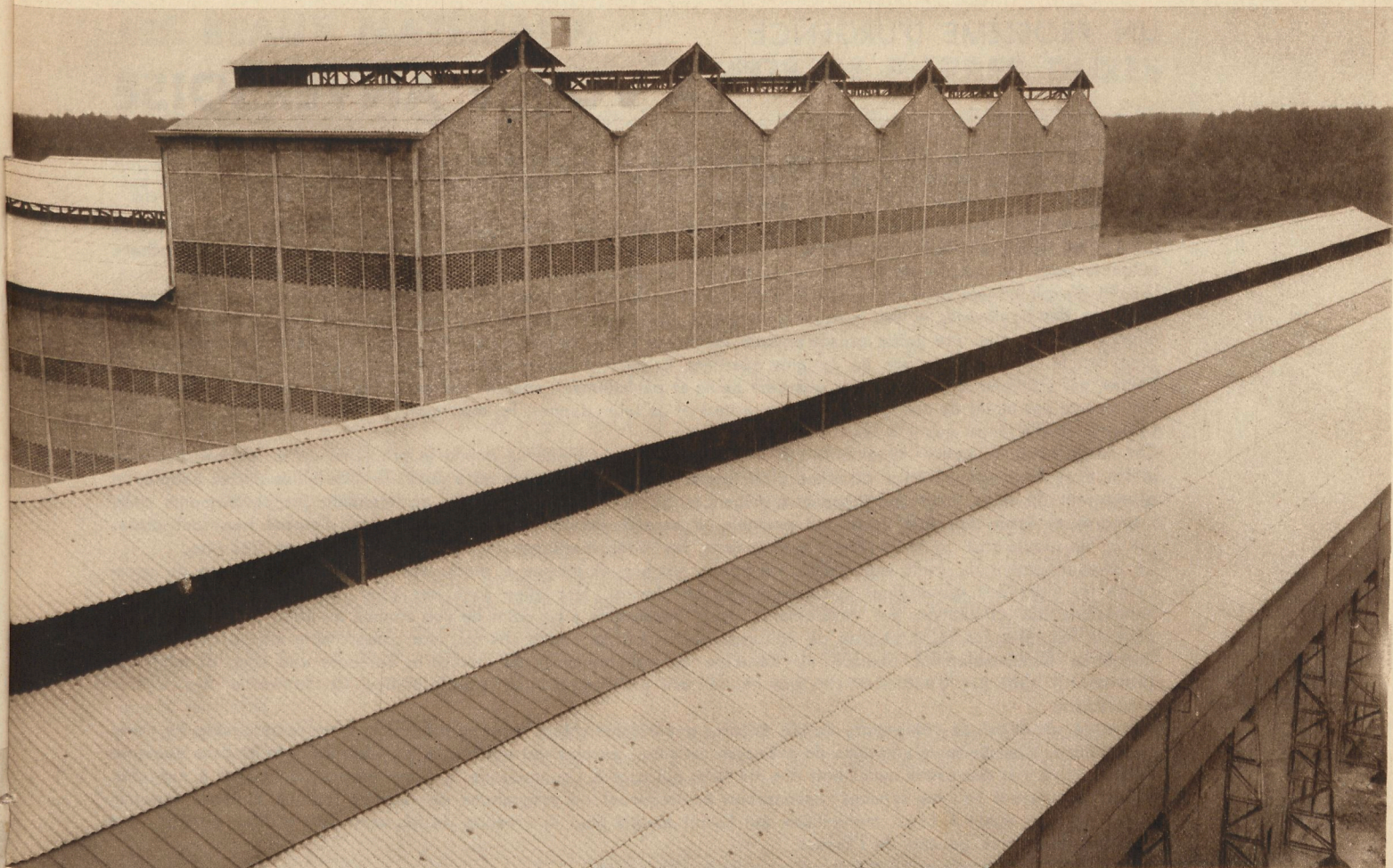
DEUX VUES DES USINES DE LA S. A. DES PRODUITS CHIMIQUES ET METALLURGIQUES DU RUPEL A RUYSBROECK — SAUVEGARDE OU PLUS DE 16,500 M 2 DE COUVERTURE EN PLAQUES ONDULEES « COVERIT » FURENT EMPLOYES. (STUDIO « BATIR », PHOTO HAYOIS.)
