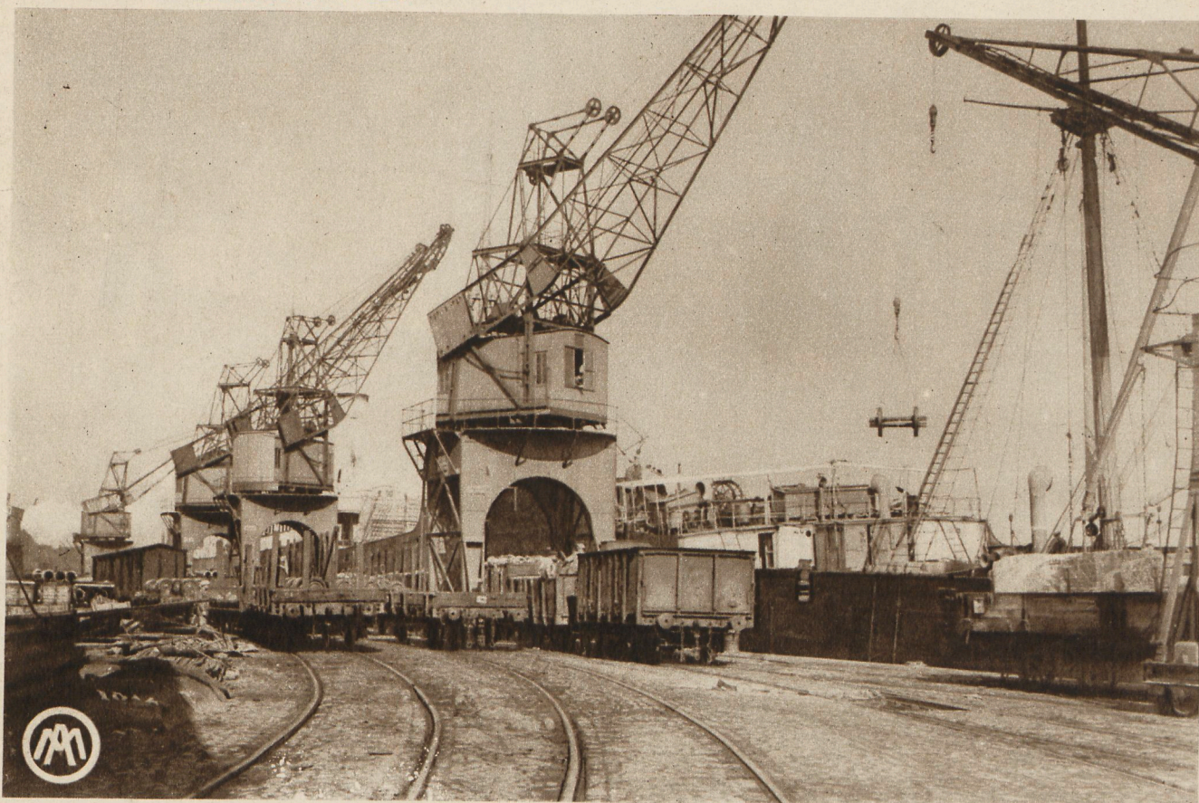
GROUPE DE GRUES ELECTRIQUES DE 3 ET 5 TONNES, D'UNE PORTEE DE 18 M. 50, AU QUAIS 125, A ANVERS. NONANTE-TROIS GRUES DE 3, 5 ET 6 TONNES ONT ETE FOURNIES PAR LA DIVISION APPAREILS DE LEVAGE ET MANUTENTION DE LA SOCIETE ANONYME LES ATELIERS METALLURGIQUES A NIVELLES, POUR L'EQUIPEMENT DU PORT.
