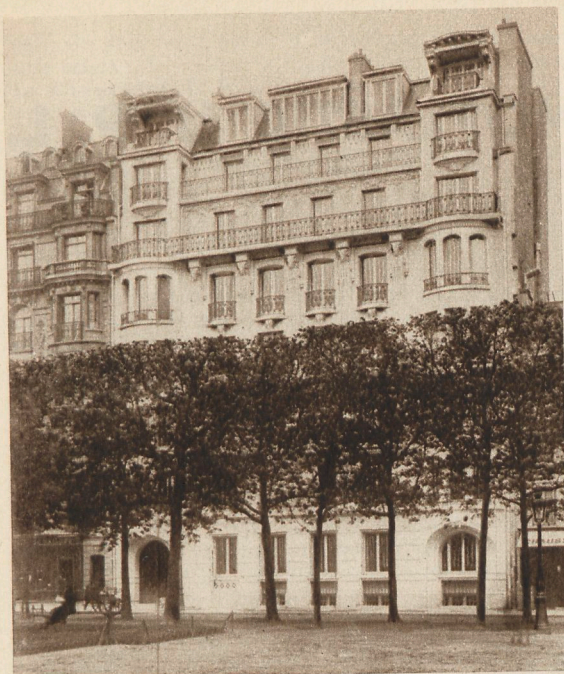
IMMEUBLE A PARIS OU LE « COLONIAL ROOFING » A ETE EMPLOYE TANT EN FONDATION QU'EN COUVERTURE.
