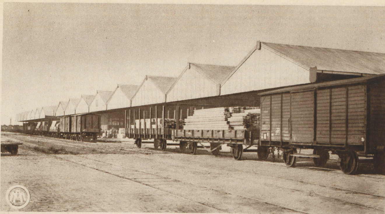
ANVERS. QUAIS 131 ET 133. DEUX HANGARS OUVERTS DE 120 M. x 56 M. COUVRANT CHACUN UNE SUPERFICIE DE 6,720 M 2 ET FORMANT PARTIE D'UN ENSEMBLE DE 32 HANGARS OUVERTS ET FERMES D'UNE SUPERFICIE TOTALE DE 168,590 M 2 , ENTIEREMENT CONSTRUITS PAR LA DIVISION PONTS ET CHARPENTES DE LA SOCIETE ANONYME LES ATELIERS METALLURGIQUES A NIVELLES.
