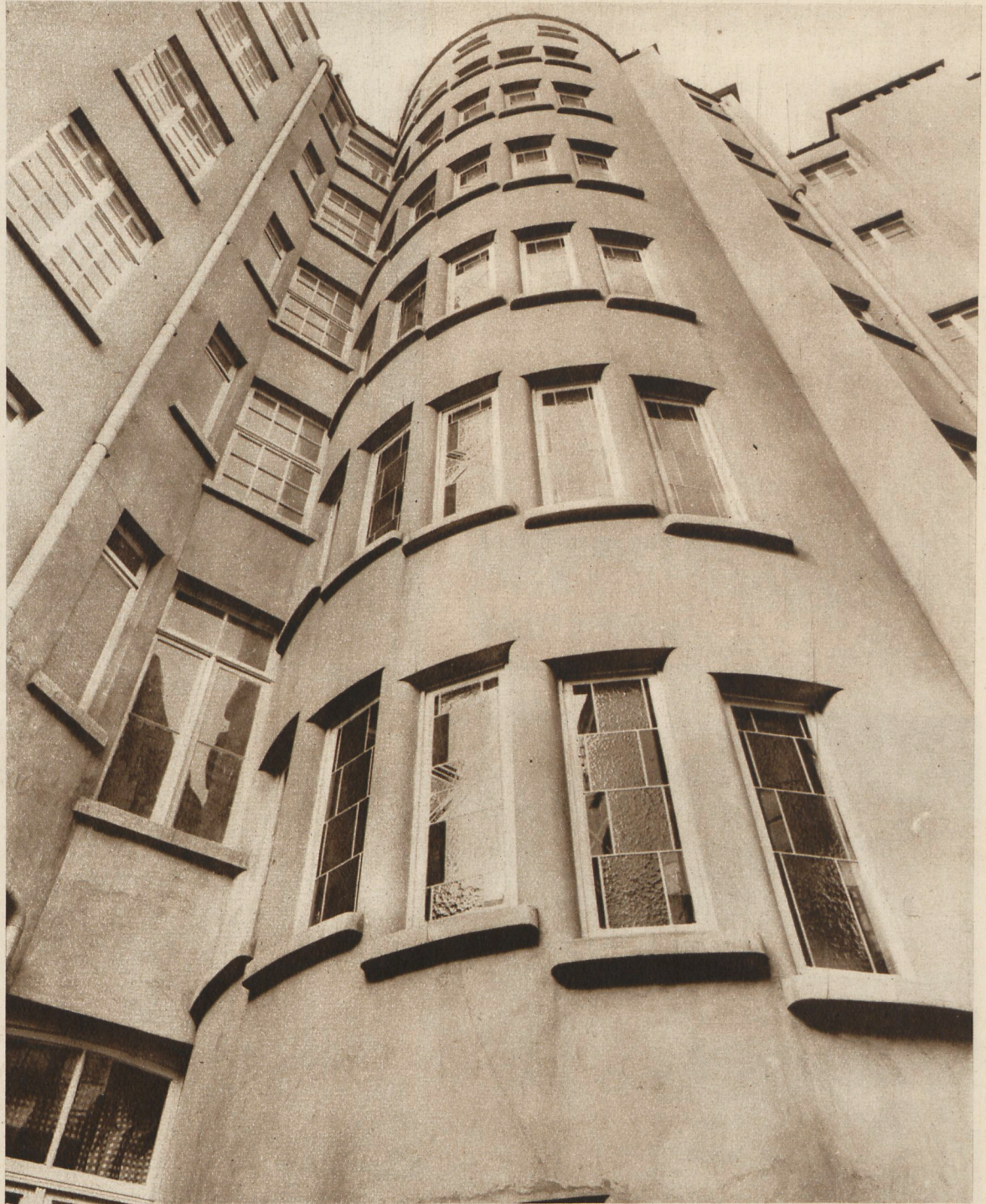
IMMEUBLE DE RAPPORT, AVENUE LOUISE. ARCH. VERLANT. ENTREPRENEUR R. GILLION. (PHOTO E. SERGIJSELS, BRUXELLES.)
