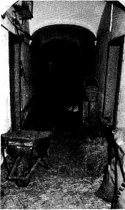
Afb. 15. De centrale gang van het souterrain, naar de diensttrap toe.
