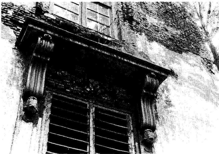
Afb. 13. Gesculpteerde bekroning van de vensters op de bel-étage van de voorgevel.
