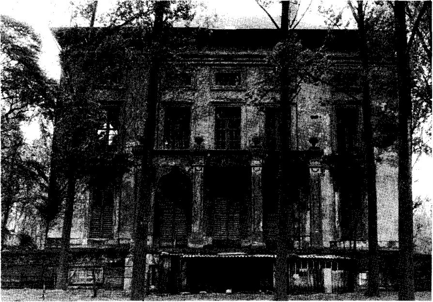
Afb. 12. De voorgevel van het kasteel in zijn huidige toestand.
