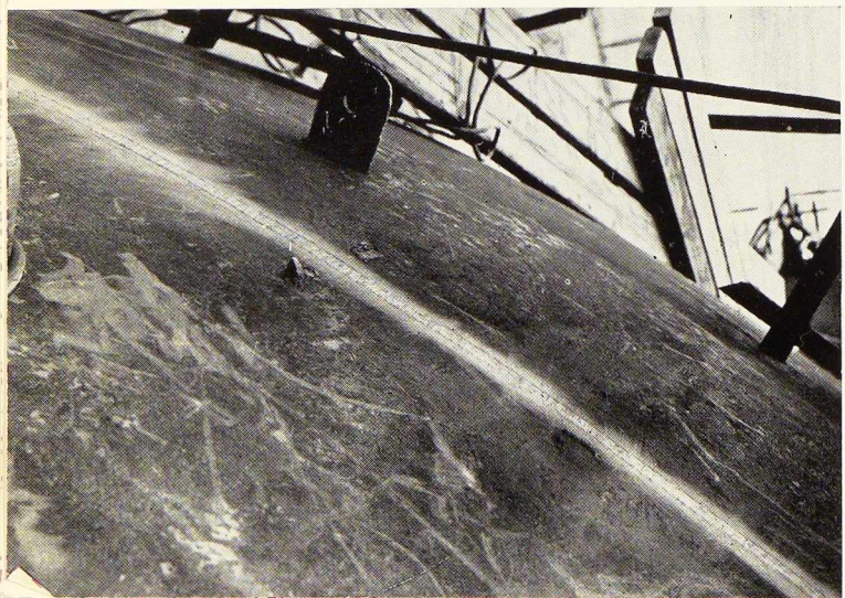
Fig. 3. Vue montrant la bonne qualité des soudures. Les oreilles, visibles à l'arrière-plan, servent uniquement à faciliter le montage et sont enlevées ultérieurement.
