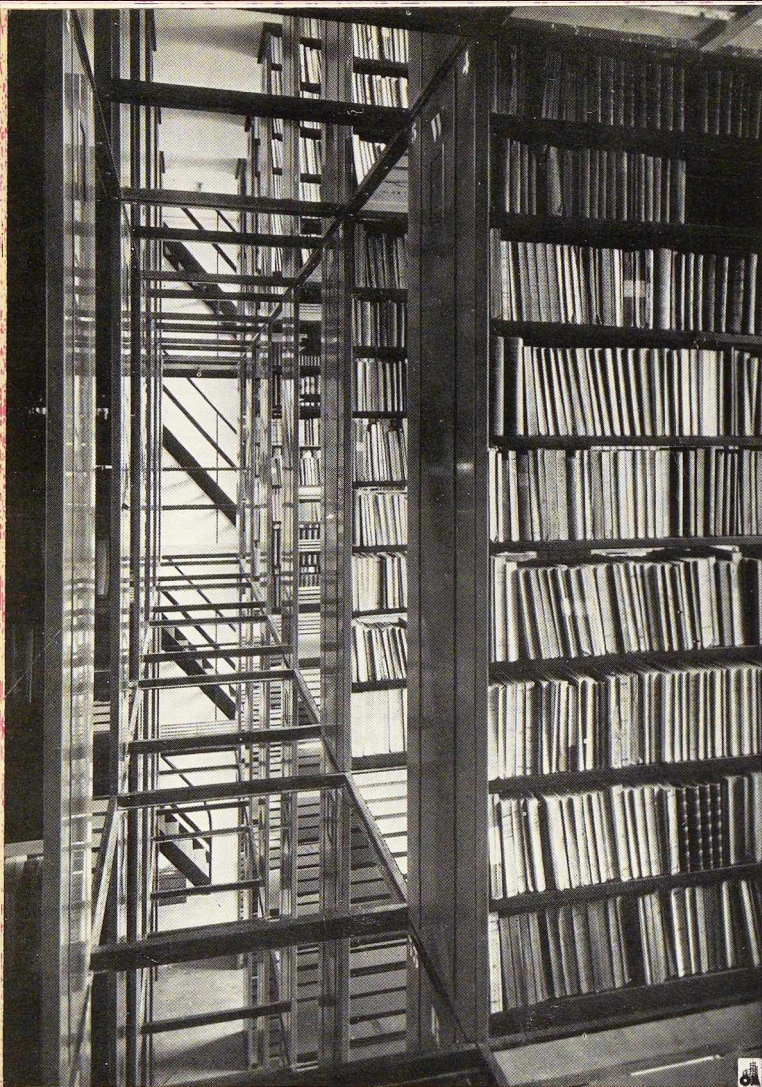
Fig. 7. Rayonnages métalliques autoporteurs sur plusieurs étages, avec passerelles intermédiaires à chaque étage.
