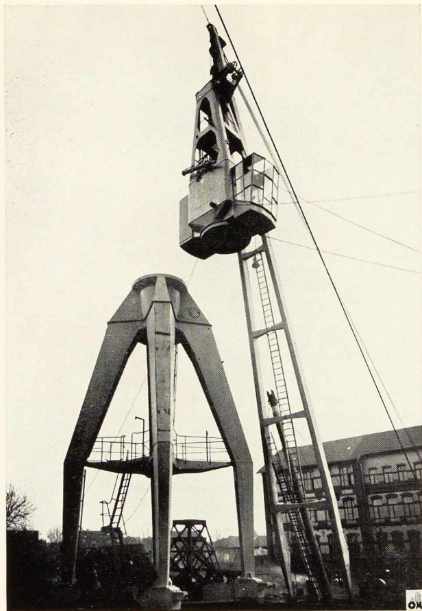
Fig. 2. Grue HB dont le montage se fait sans emploi d'appareils de levage spéciaux.
