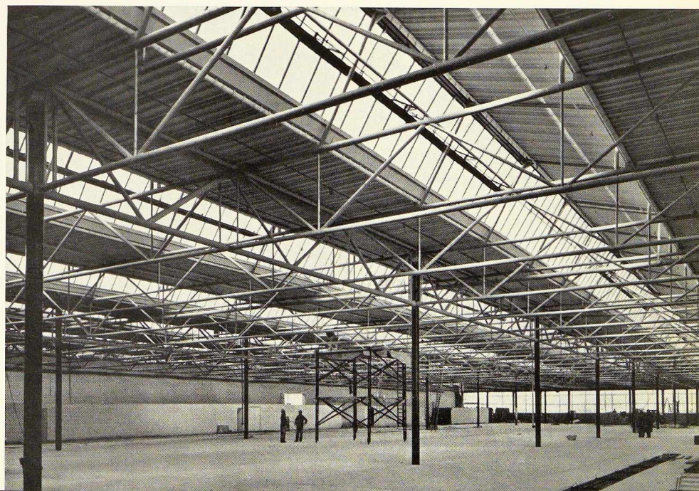
Fig. 12. Usines Tubewrights à Kirkby, près de Liverpool. Vue intérieure de la charpente tubulaire, prise quatorze semaines après le début des travaux.
