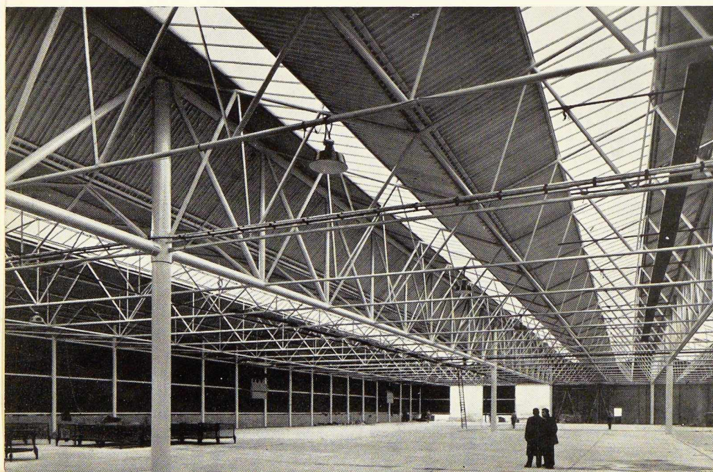
Fig. 10. Usines Tubewrights Ltd. à Kirkby. Vue intérieure de l'atelier principal.
