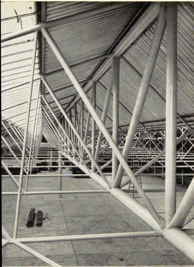
Fig. 5. Usines Tubewrights. Charpente de la toiture. Au premier plan, nœud d'éléments tubulaires assemblés par soudure.
