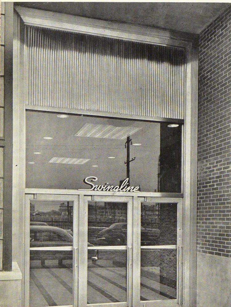
Fig. 3. Entrée d'un immeuble commercial.
