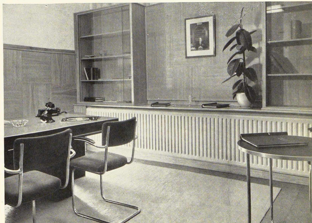
Fig. 14. Bureau équipé d'un radiateur à panneaux.
