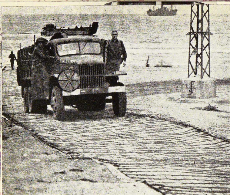
Fig. 17. Rouleau de treillis « Sommerfeld Track » déroulé sur le sable d'une plage, permettant le passage aisé des véhicules à roues débarqués.
