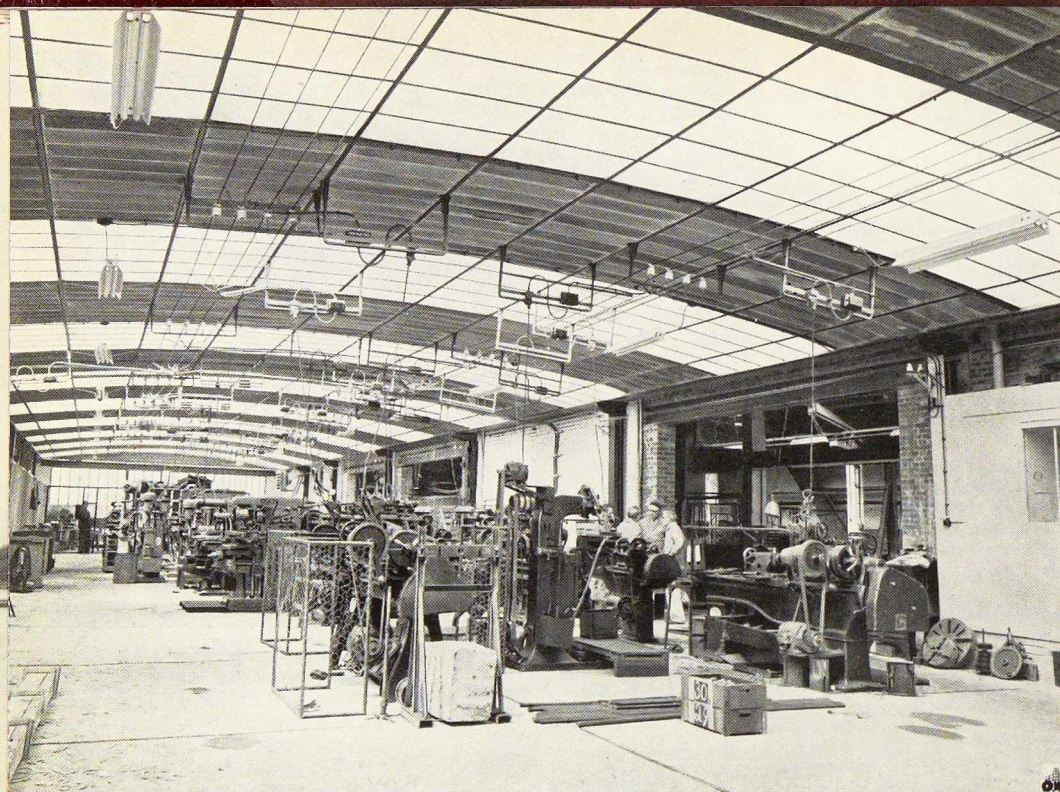
Fig. 1. Vue d'un atelier dont la toiture est portée par une charpente en arc de 12 m de portée.
