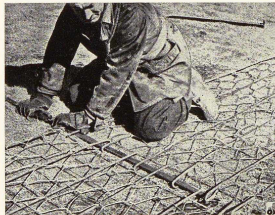
Fig. 18. Pose de « Sommerfeld Track » sur une plage. Deux rouleaux de Sommerfeld sont déroulés parallèlement, côte à côte, de façon à former double piste de roulement. Le même fer plat longitudinal est passé dans les œillets d'extrémité des fers ronds transversaux. Des piquets-cornières courts fixent ce fer plat dans le sable.
