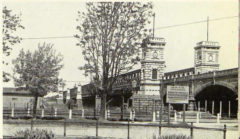
Fig. 1. Vue de l'ancien pont « Reichsbrücke » construit en 1876.
