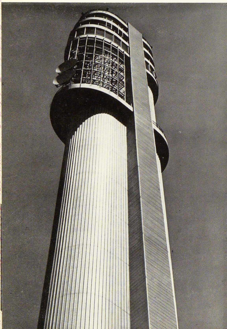
FIG. 10. TOUR D'ÉMISSION DE TÉLÉVISION À MANHATTAN (New-York), 1952. Architectes : Griffels & Vallet, Inc. et L. Rossetti. Le progrès scientifique suscite l'apparition dans l'espace de volumes inédits. Solution correcte et élégante d'un programme nouveau. Tour cylindrique à ossature d'acier. Hauteur 91 m. Les panneaux de revêtement en aluminium ( 6,10 \times 0,20 cm) accusent le mouvement ascensionnel et la flexibilité de l'ouvrage.
