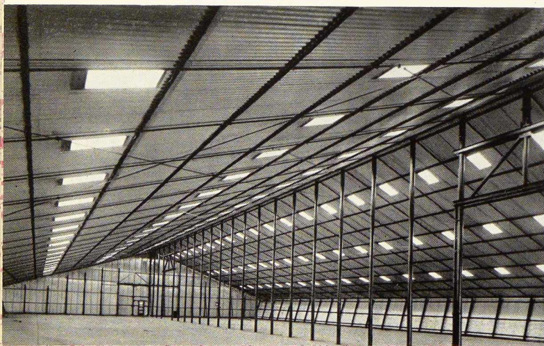
Fig. 8. Vue intérieure d'un hangar haubané, construit en Grande-Bretagne pour le Ministère du Ravitaillement.
