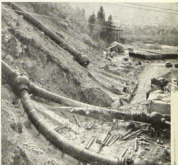
Fig. 6. Chute de Malgovert. Collecteurs de distribution d'un type spécial à lyre intérieure, en cours de montage.
