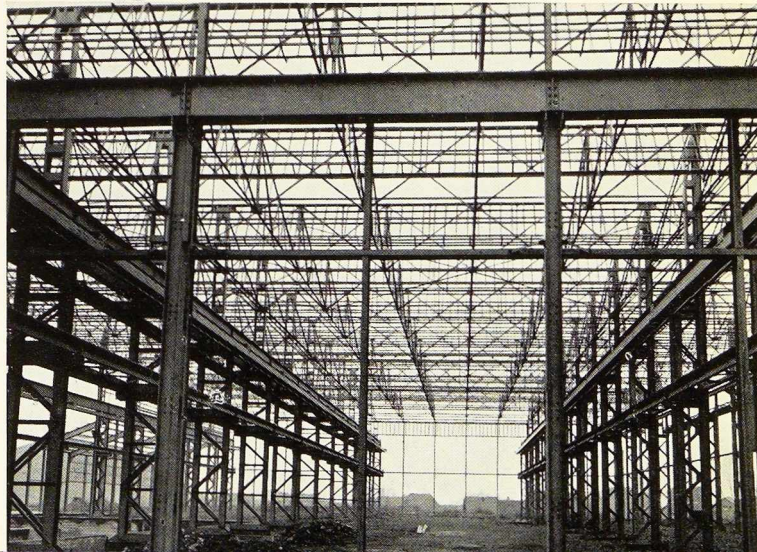
Fig. 2. Ossature métallique des bâtiments des Forges, Usines et Fonderies de Gilly.
