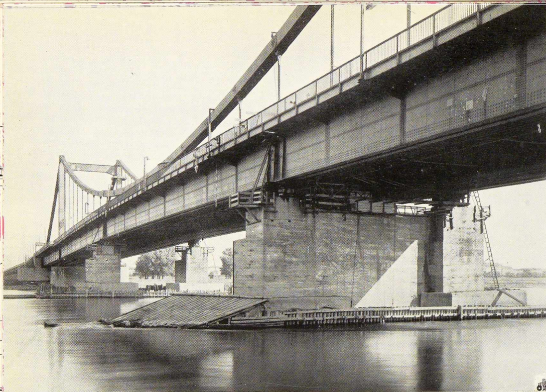
Fig. 12. Pile auxiliaire côté Vienne après consolidation, avec le mur intermédiaire et le bec brise-glace (à l'avant-plan).
