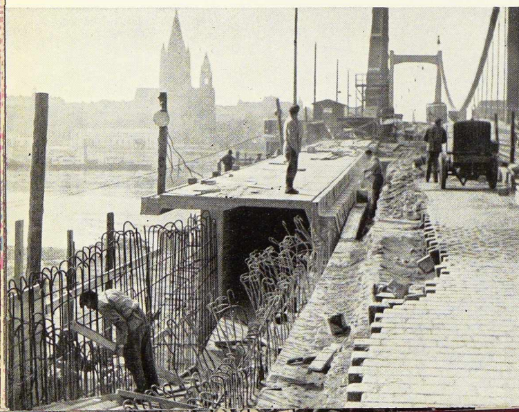
Fig. 3. Travaux de réfection des voûtes endommagées du pont de crue.
