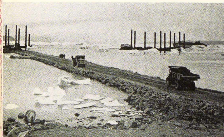
Fig. 6 (ci-dessus). Une phase de la construction d'un quai d'accostage au moyen de « dodécapodes » lors de la création de la Base aérienne américaine de Thulé (Groenland).
