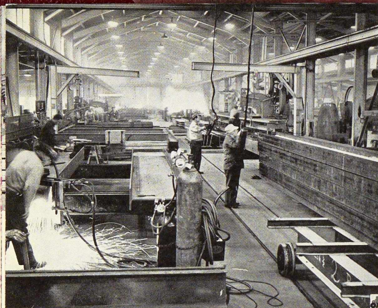
Fig. 10. Vue intérieure des ateliers de construction de la Luria Engineering Company à Bethlehem où sont fabriquées, à la chaîne, des charpentes standardisées.
