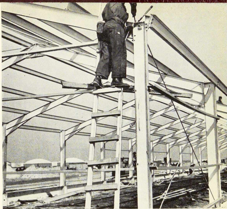
Fig. 4. Le montage de la charpente d'un hangar à l'aéroport d'Idlewild à New York.
