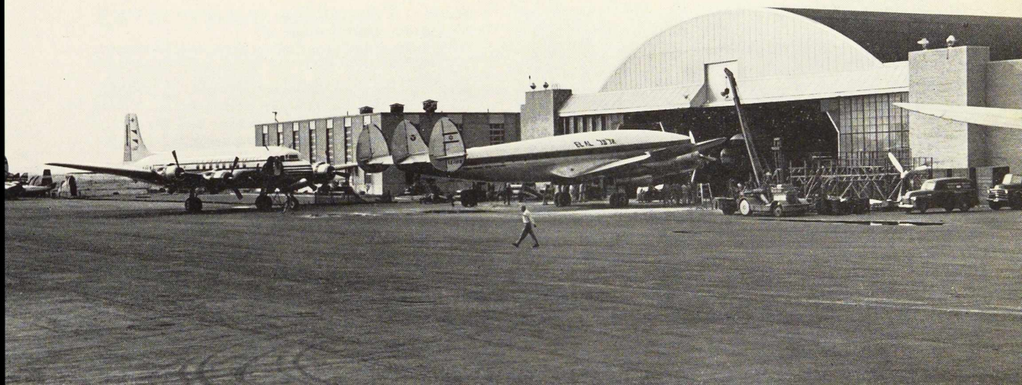
Fig. 4. Vue d'ensemble du nouveau hangar du Service international des avions Lockheed, récemment construit à l'aéroport de Idlewild à New-York.
