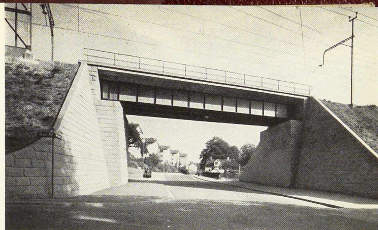
Fig. 6. Passage inférieur de la Wasserwerkstrasse à Zurich. Portée : 19,47 m.
