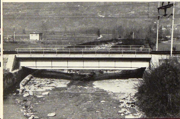
Fig. 9. Pont sur la Morobbia. Portée : 20,70 m.
