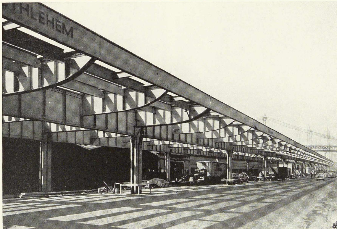
Fig. 5. Superstructure métallique du nouveau viaduc de la South Street aux lignes sobres et nettes.
