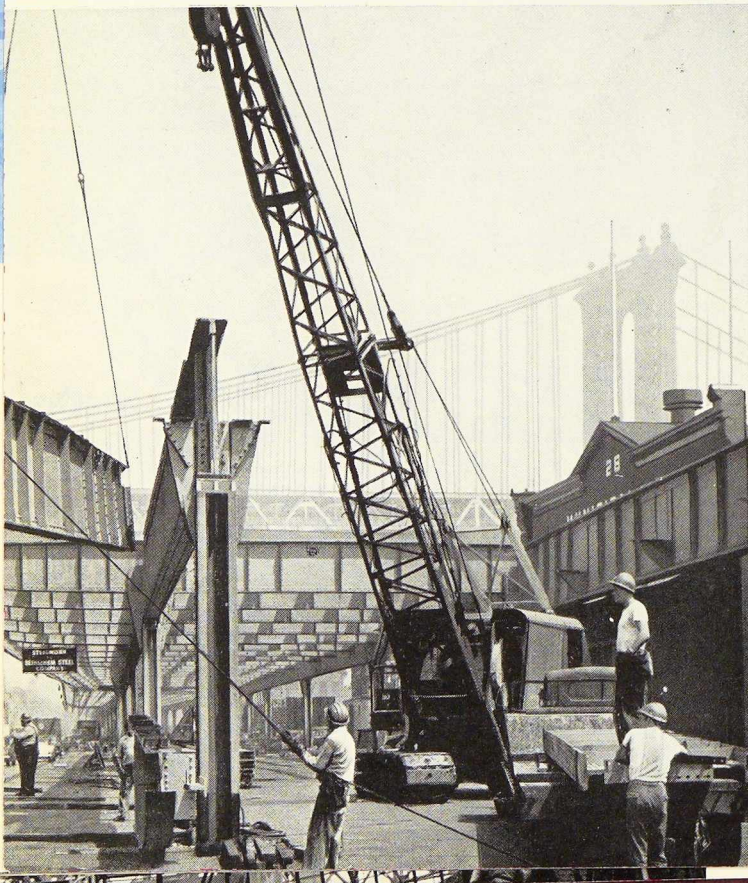
Fig. 4. Mise en place d'éléments de la charpente métallique au moyen d'une grue roulante.
