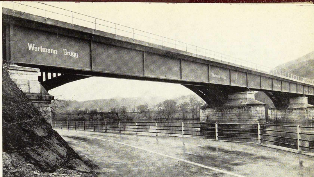
Fig. 10. Vue générale du nouveau pont de Tannwald sur l'Aar à Olten.
