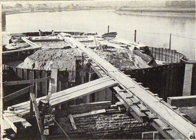
Fig. 27. Remplissage du musoir en palplanches plates de la figure 25.
