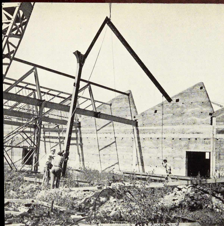
Fig. 3. Mise en place d'un élément de l'ossature métallique du Centre Technique de Vienne.
