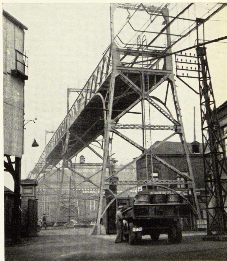
Fig. 6. Support décapé et peint aux usines John Cockerill à Seraing.
