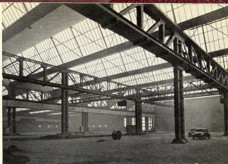
Fig. 4. Poutres en treillis constituant le système portant du Palais des Expositions à Charleroi.
