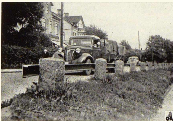
Fig. 3. Barrière de garde en acier pour la sécurité des routes (Suède).
