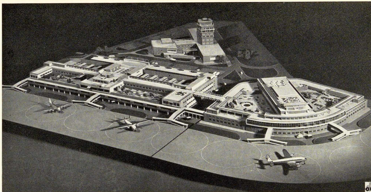
Fig. 10. Vue d'ensemble des bâtiments de l'aérogare groupés au centre de l'aéroport de Londres. Photo Wainwright.
