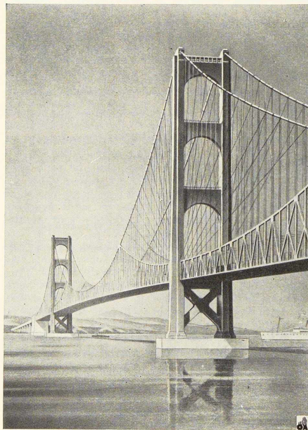
Fig. 25. Pont sur le détroit de Messine, pour relier la Sicile à l'Italie. Travée principale de 5 000 pieds, qui sera la plus longue du monde. Type rigide de treillis raidisseur et système radiant de haubans en câbles pour assurer la stabilité aérodynamique (projeté par l'auteur).
