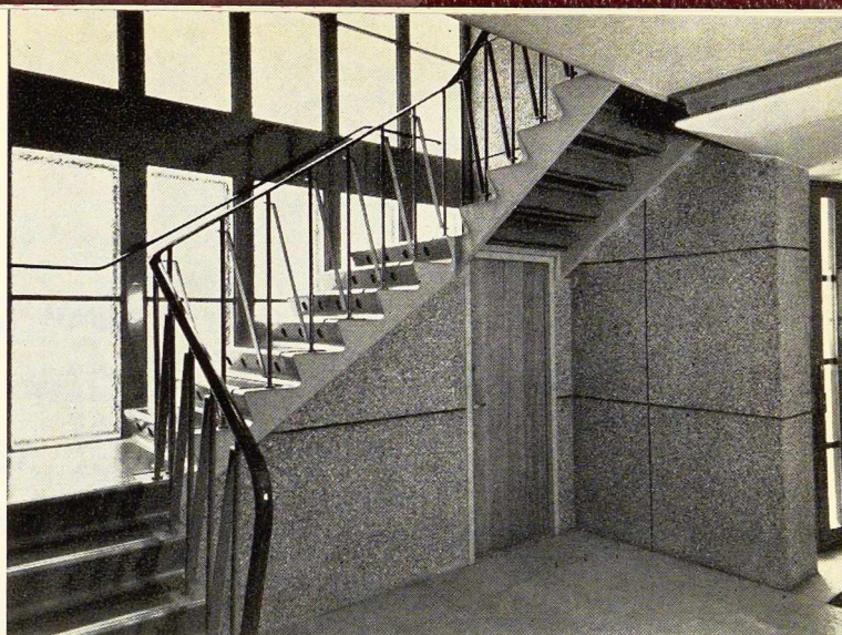
Fig. 2. Escalier en tôle pliée et soudée.
