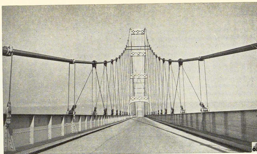
Fig. 26. Haubans intermédiaires pour réduire les oscillations aérodynamiques. Leur installation au pont de « Deer Isle », dans le Maine, 1943.
