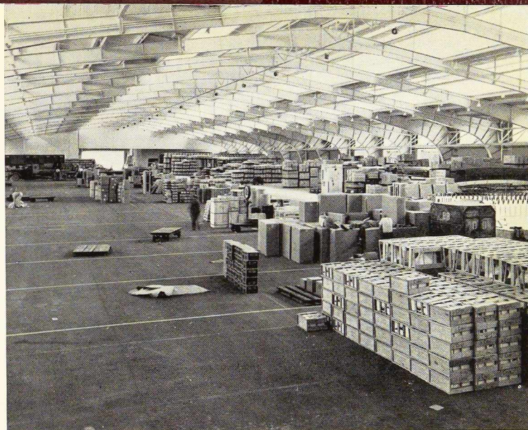
Fig. 3. Intérieur du hangar pour marchandises. L'ossature métallique est constituée de portiques soudés de 60 m de portée.
