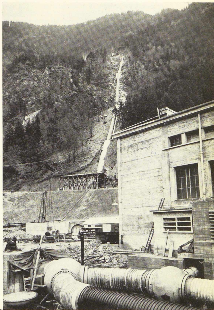
Fig. 6. Le collecteur de la conduite forcée de Passy (Alpes), puissance de 130 000 CV, est en partie bétonné et en partie remblayé. Les culottes de bifurcation se trouvent dans des chambres visitables. C'est pourquoi on peut distinguer trois enduits différents sur cette photographie :
