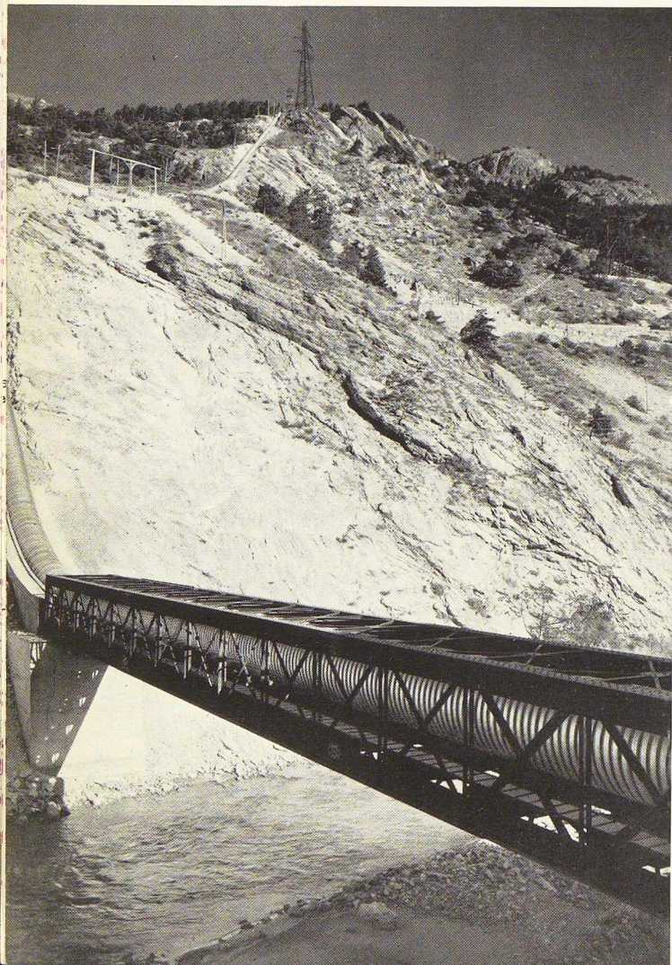
Fig. 5. La conduite forcée d'Aussois, puissance de 130 000 CV, est exposée au Sud. Elle a reçu deux couches de peinture aluminium qui devront être entretenues régulièrement pour conserver aux couches de fond leur entière efficacité. La teinte aluminium permet également de réduire l'échauffement de la conduite vide et d'utiliser, à l'intérieur, des revêtements susceptibles de se ramollir et de fluer au-dessus de 50°.
