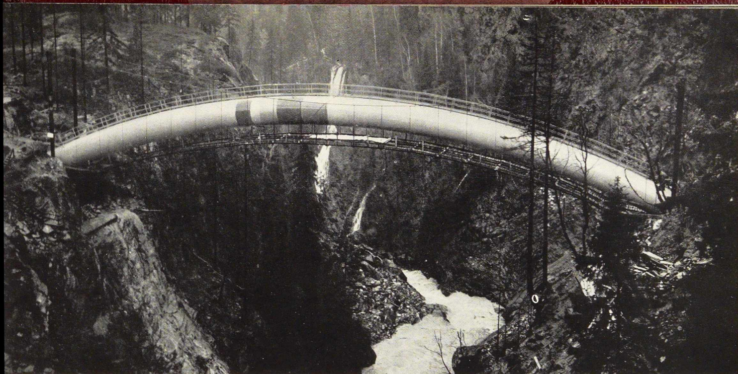
Fig. 4. Lorsque les conduites forcées se trouvent dans des sites classés, elles doivent recevoir une protection d'une teinte agréée par la Commission des Sites. Ci-dessus un essai de différentes teintes sur le Siphon de Passy, diamètre 3 m, portée 70 m (record du monde). Après terminaison des travaux, la passerelle de service est démontée.
