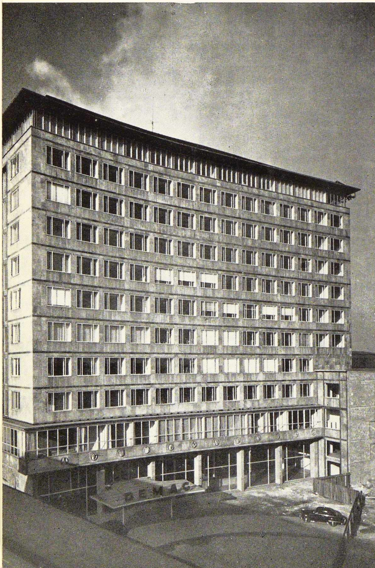
Fig. 3. Façade principale du nouveau bâtiment Demag, à Duisburg.
