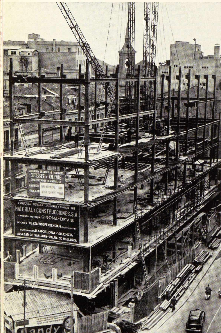
Fig. 2. Ossature métallique des Grands Magasins « Galerías Preciados » à Madrid, en cours de montage.
