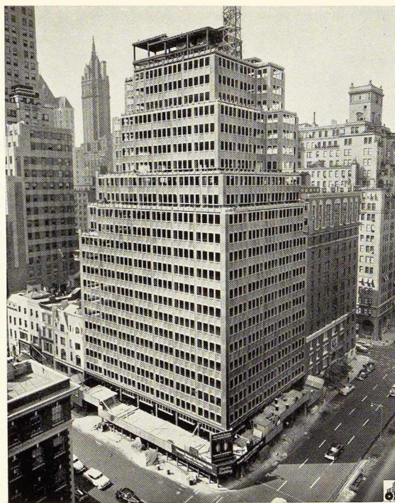
Fig. 7 et 8. Deux aspects d'un gratte-ciel new-yorkais de 22 étages. A gauche, le début de la mise des panneaux de revêtement des façades. A droite, l'opération est entièrement terminée, 10 heures après le coup de sifflet initial du contremaître.
