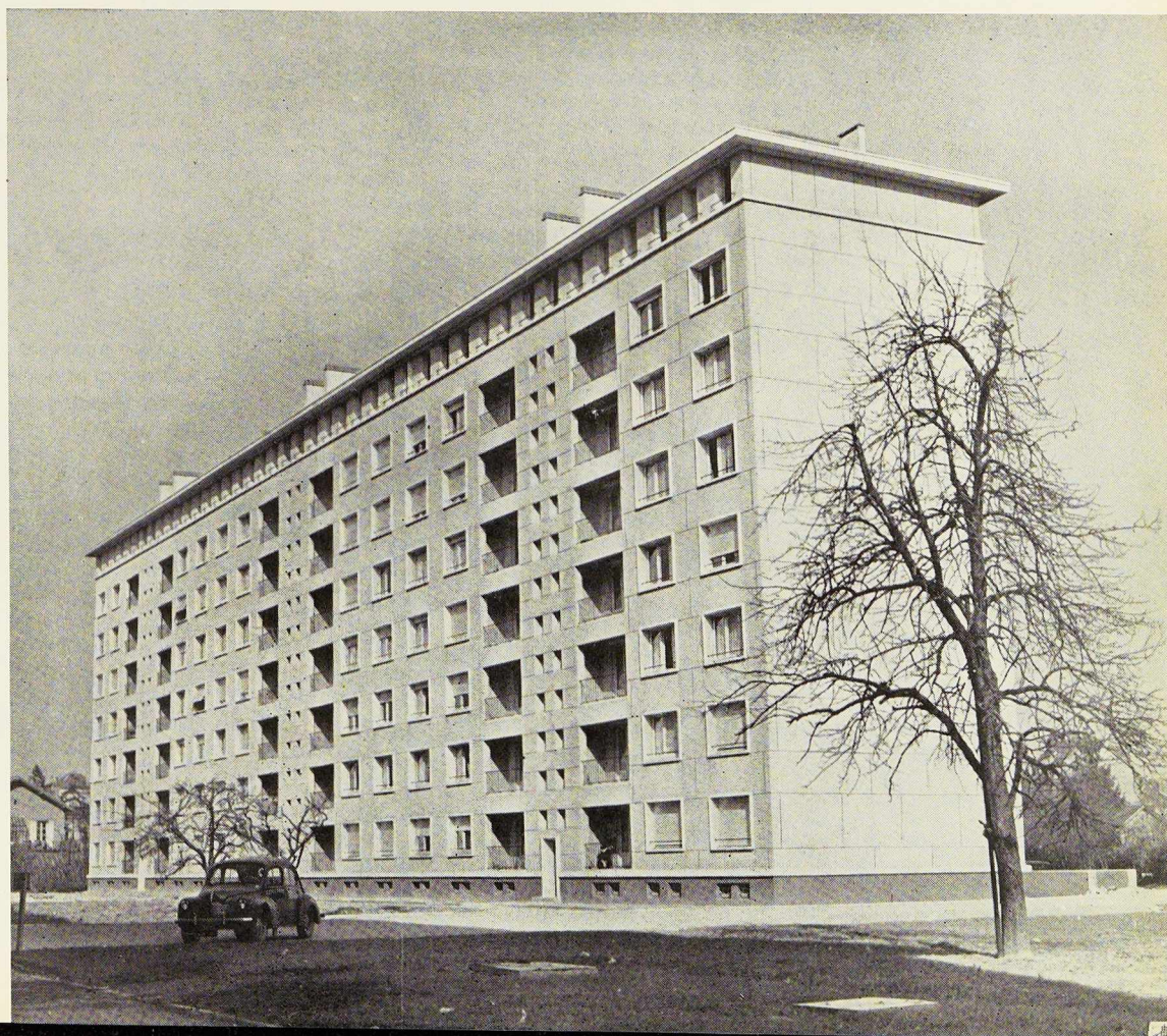
Fig. 2. Vue d'un immeuble de sept étages. Des contreventements dans les pignons, les deux portiques transversaux et les travées extrêmes des façades, ainsi que des contreventements horizontaux dans les planchers, assurent la stabilité de la construction.
