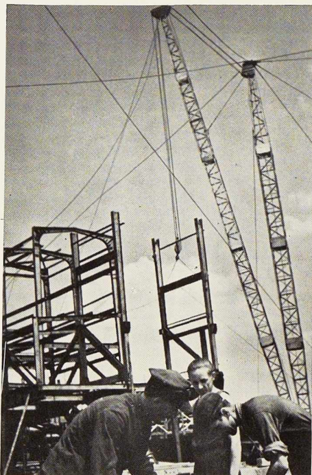
Fig. 3. Charpente soudée d'un haut fourneau de l'usine Nowa Huta (Pologne) en cours de montage.
