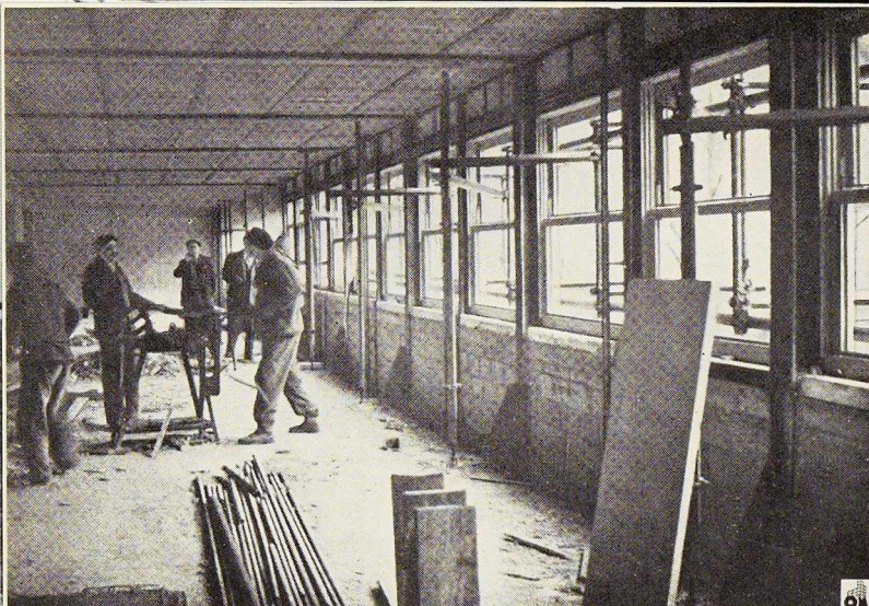
Fig. 6. Vue intérieure d'une partie de l'immeuble montrant les ensembles de fenêtres en acier.
