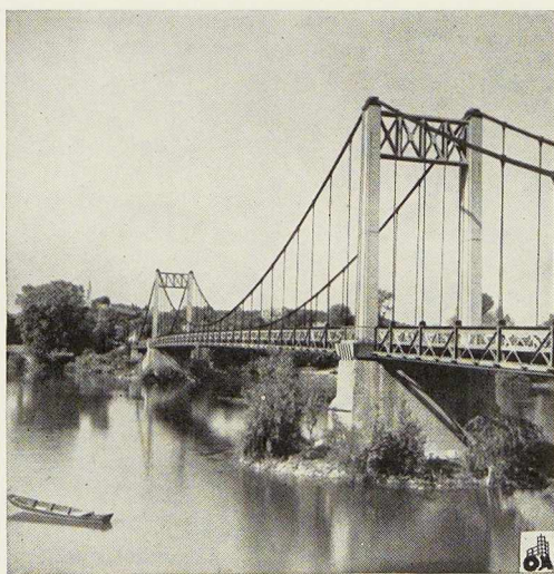
Fig. 4. Vue d'enfilade du pont des Rosiers.
