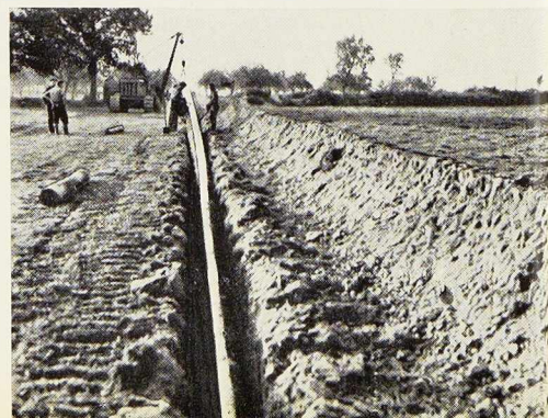
Fig. 6 à 8 (De gauche à droite). Apport de tubes et mise bout à bout par side-boom . Machine à nettoyer et à enduire et side-boom porteur. Mise en fouille.
