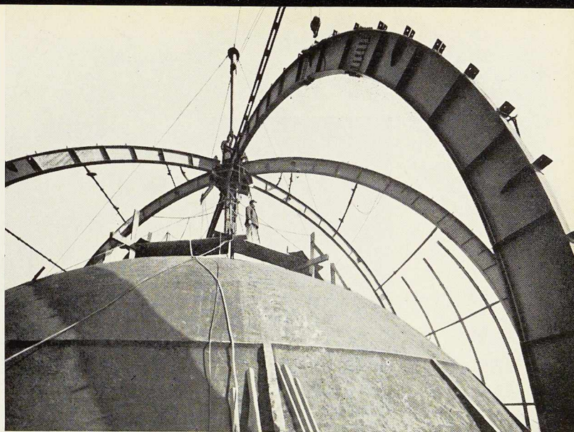
Fig. 5. Mise en place d'un demi-arc par le derrick central visible sur la figure 6.
