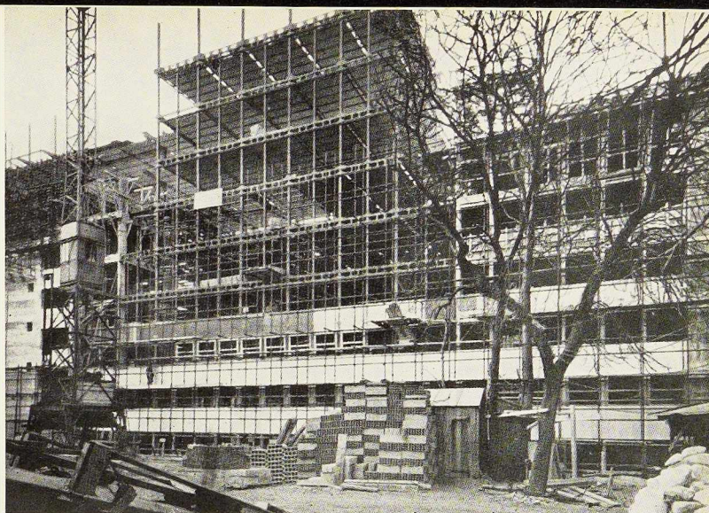
Fig. 2. Ossature métallique de l'immeuble 6, rue Rabelais, à Paris.
