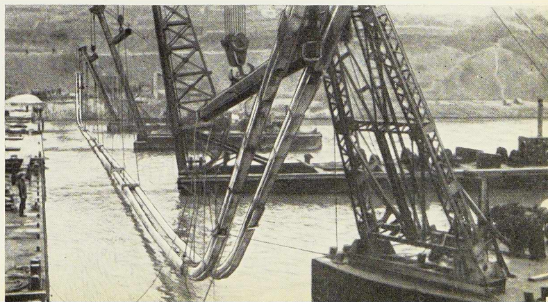
Fig. 10. Soulèvement du pipe-line par pontons-grues avant immersion pour la traversée de la Seine à Gennevilliers.
