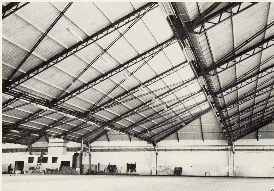
Fig. 4. Garage D'Ieteren Frères à Bruxelles. Les poutres placées dans le plan incliné de la toiture assurent un éclairage largement réparti.
