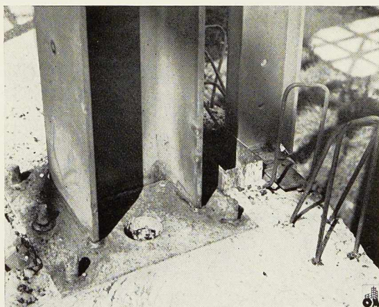
Fig. 9. Détail d'encastrement des poteaux. Photos Grob.
