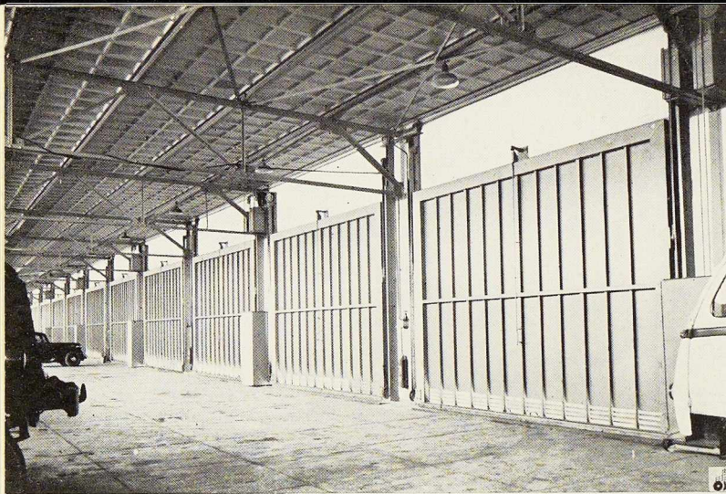
Fig. 15. Garages pour autos couvrant environ 1 900 m 2 . La couverture est en plaques de béton de Bims revêtues d'une couche imperméable (voir également figures 16 à 18).
