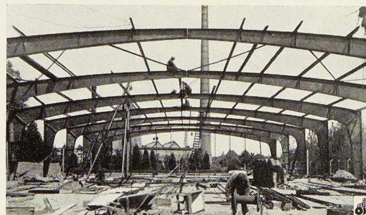
Fig. 2 et 3. Garage d'autobus municipaux couvrant 845 m 2 . Poids total de la charpente 45 tonnes.
