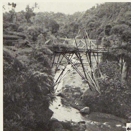
Fig. 3. Pont à ossature en bambous à Bali (Indonésie).
