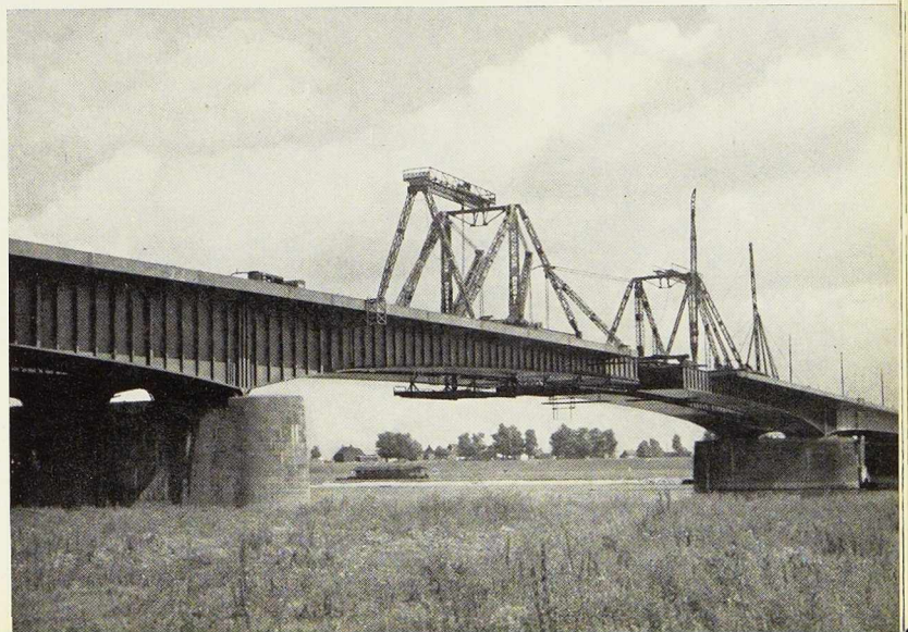
Fig. 29. Montage en porte à faux de la travée centrale.
