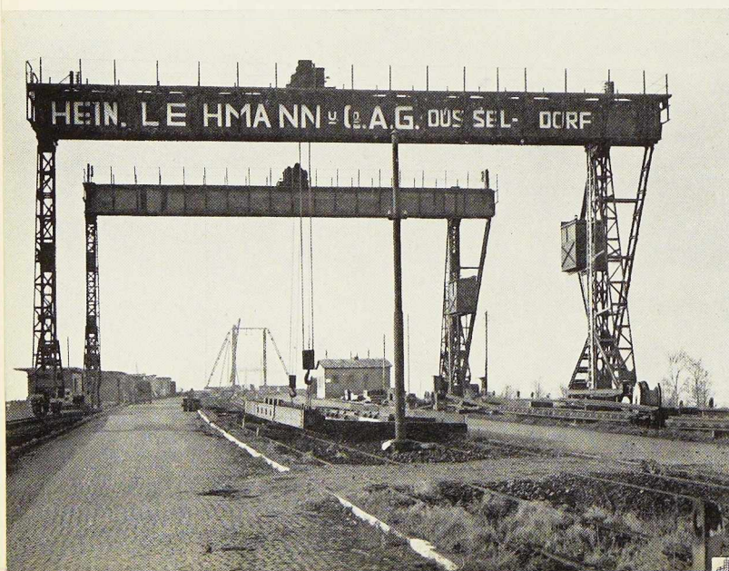
Fig. 25. Portique pour le redressement des éléments amenés par la route.
