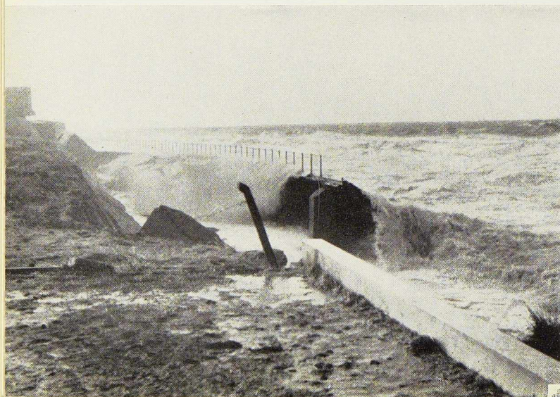
Fig. 4. Une vue de la brèche faite dans la digue au Lekkerbek-Le-Zoute.
