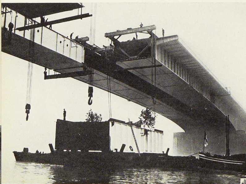
Fig. 32. Mise en place du dernier élément du caisson aval.
