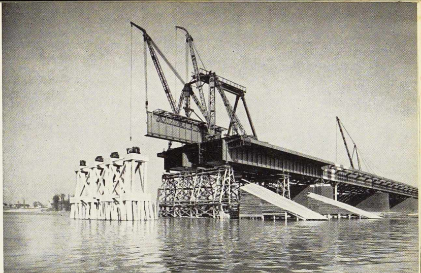
Fig. 28. Montage de la travée latérale sur piles en rivière.
