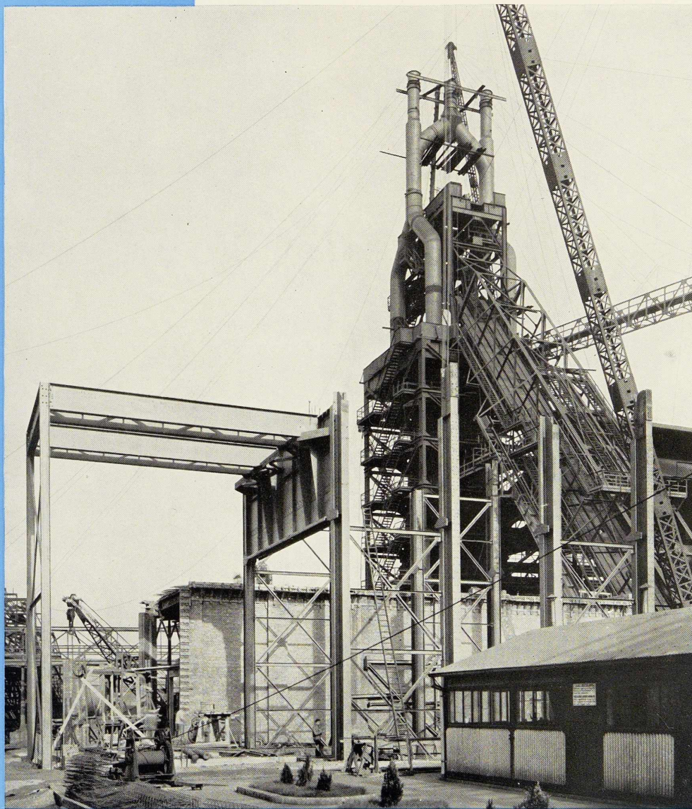
VUE PARTIELLE D'UNE INSTALLATION COMPLÈTE DE HAUT FOURNEAU EN COURS DE MONTAGE
