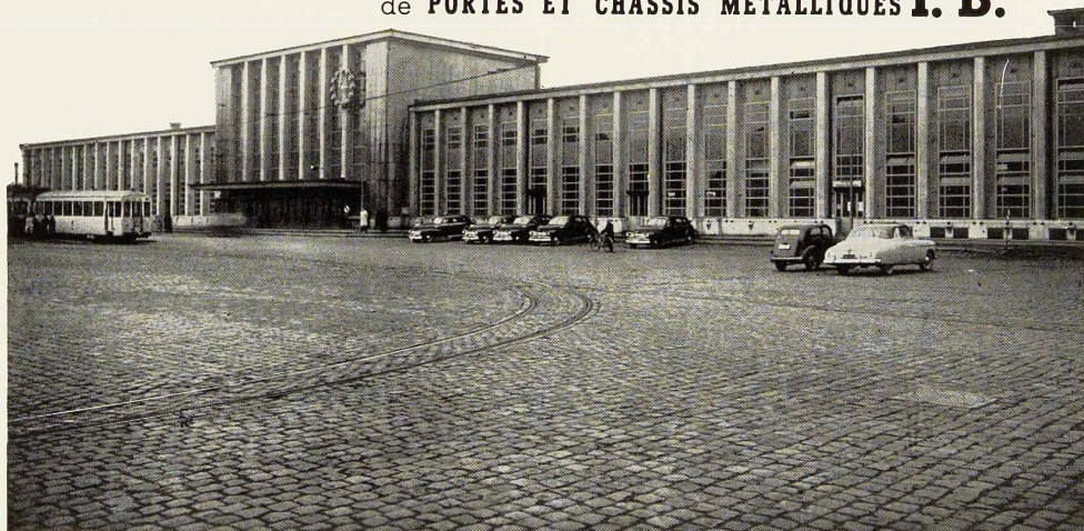
Vue de la façade principale de la gare de Mons. Architecte : R. Panis - Parachèvement : Entreprises Générales L. Leturcq, Tournai.
