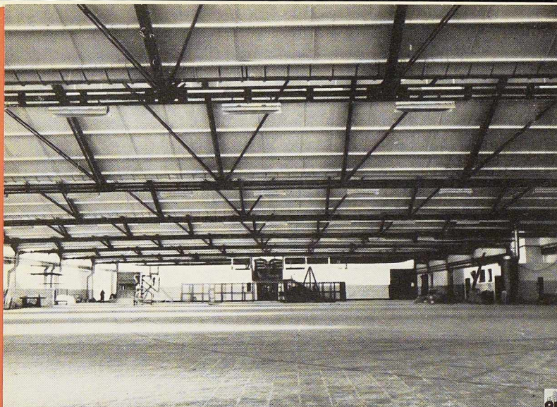
Fig. 1. Vue intérieure du garage d'Ieteren, chaussée de Mons à Bruxelles. Notez l'absence de tout poteau gênant la manœuvre des voitures.
