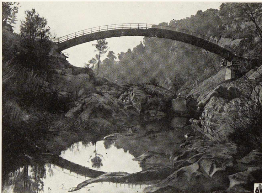
Fig. 3 (à droite). Vue d'ensemble de l'arc tubulaire construit au canal de Verdon. A ses extrémités l'arc est encastré dans des blocs massifs en béton.
