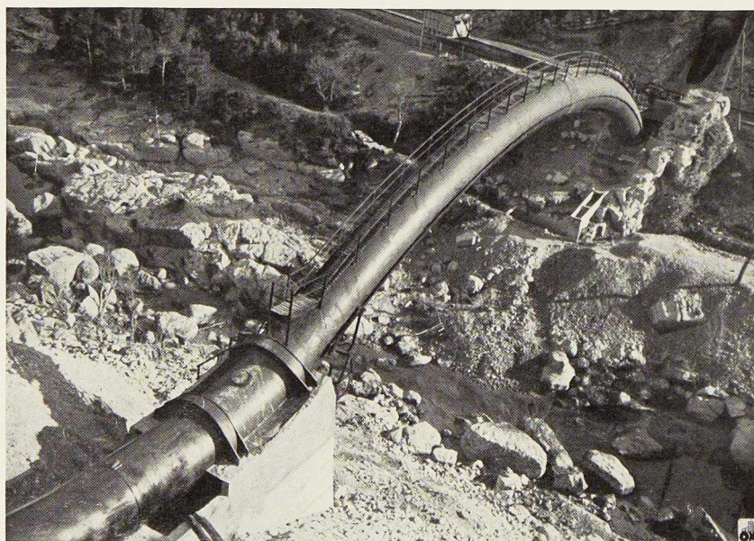
Fig. 4 (ci-dessous). Vue aérienne de l'arc tubulaire montrant le détail des appuis.
