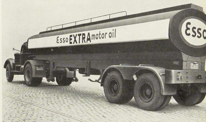
Fig. 6. Tracteur avec remorque-citerne pour le transport de l'essence.
