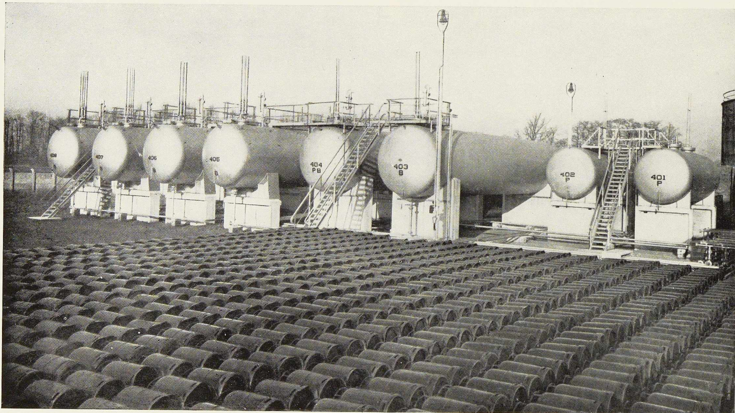
Ci-dessus : Réservoirs de stockage à propane et butane construits à nos ateliers. (Capacité : 110 m 3 ).
