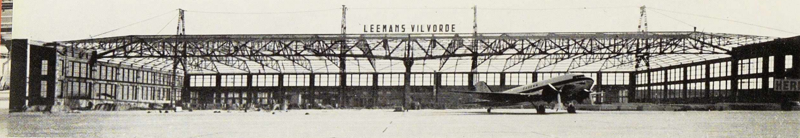
Fig. 5 et 6. Hangar pour avions lourds construit à l'aéroport de Melsbroeck. La poutre continue préfabriquée a une longueur totale de 152 m.
