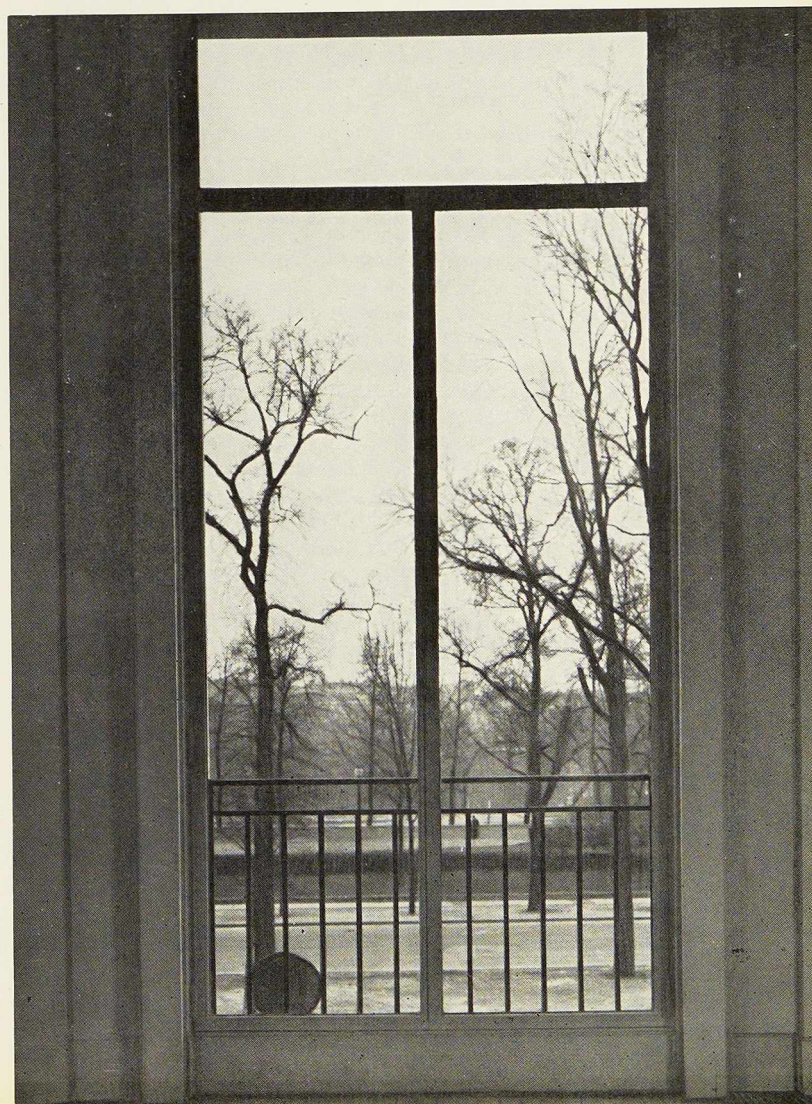
Fig. 14. Menuiserie métallique d'un immeuble situé quai Branly à Paris. Document OTUA. Photo Lachery.
