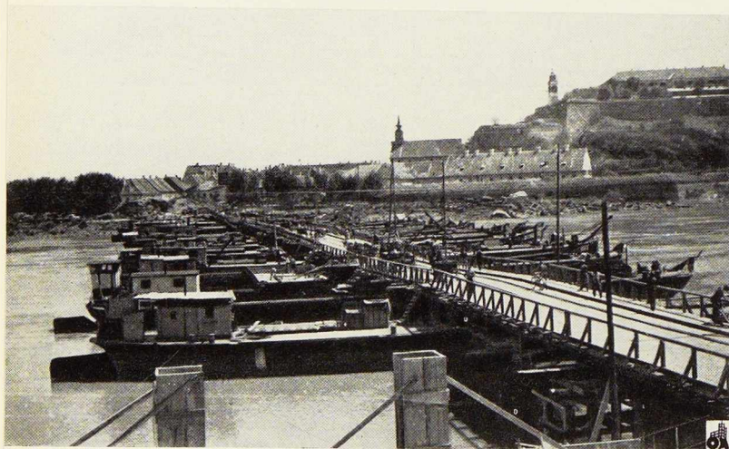
Fig. 9. Pont flottant provisoire sur le Danube près de Novi-Sad. Le pont est construit sur chalands; le système portant est constitué par des poutrelles à larges ailes.
