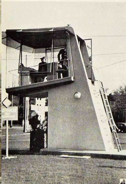
Fig. 11. Cabine de dispatching pour tramways à Hanovre, réalisée complètement en acier soudé.
