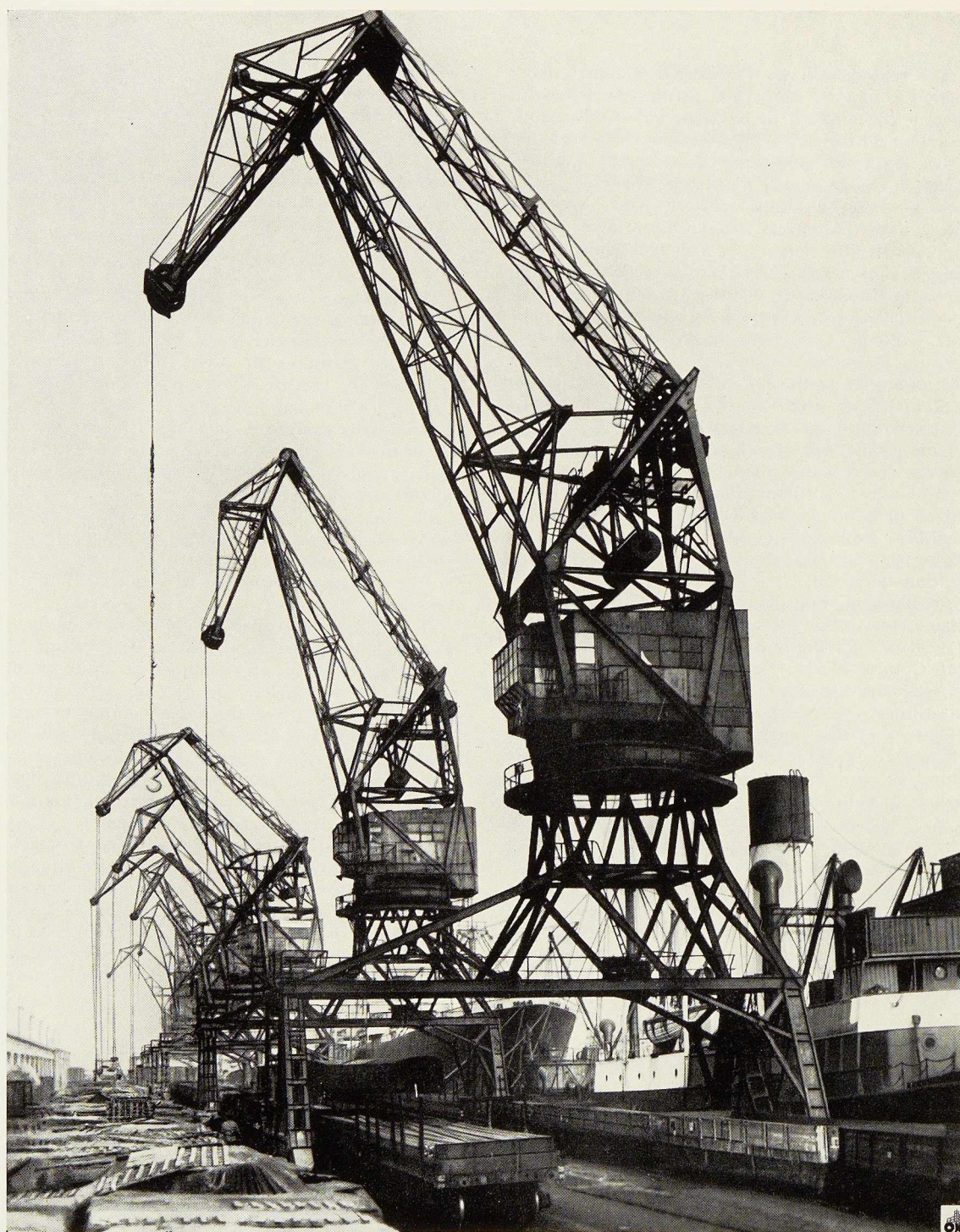
Fig. 1. Grue Paindavoinne de 6 tonnes en service au port de Dunkerque. (Un engin du même type existe également au Port Autonome de Strasbourg.)
