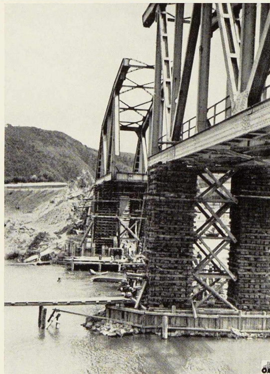
Fig. 17. Vue d'un pont dans les gorges de l'Ibar. Supports de grande hauteur (13 m) réalisés en traverses.
