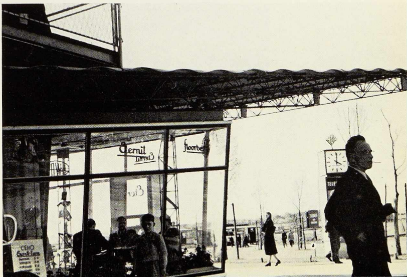
Fig. 12. Abri-parapluie de construction métallique à Hanovre.
