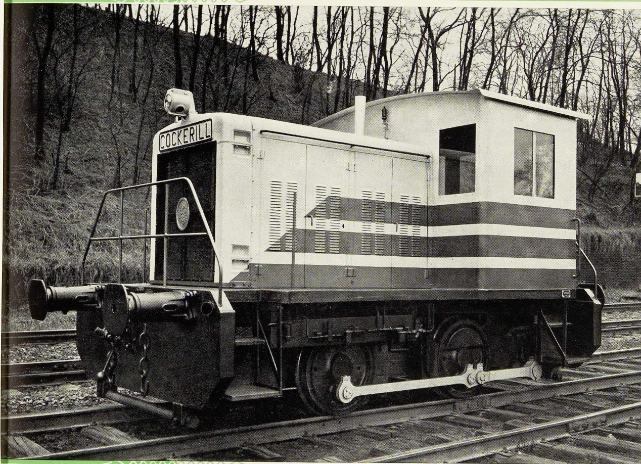
Locomotive Diesel hydraulique de 32 tonnes pour manutention dans les usines
