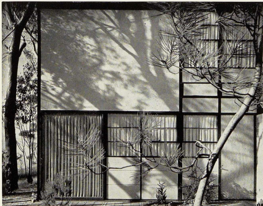
Fig. 5. Vue de la façade latérale. La porte de gauche donne accès à la salle à manger, la porte de droite conduit vers le studio-bar.
