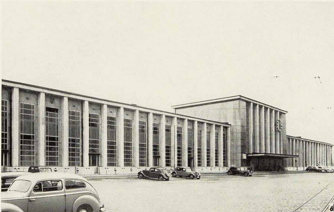
Fig. 3. Gare de Mons. Architecte : M. Panis. Châssis fournis par la S. A. l'Industrielle Boraine.
