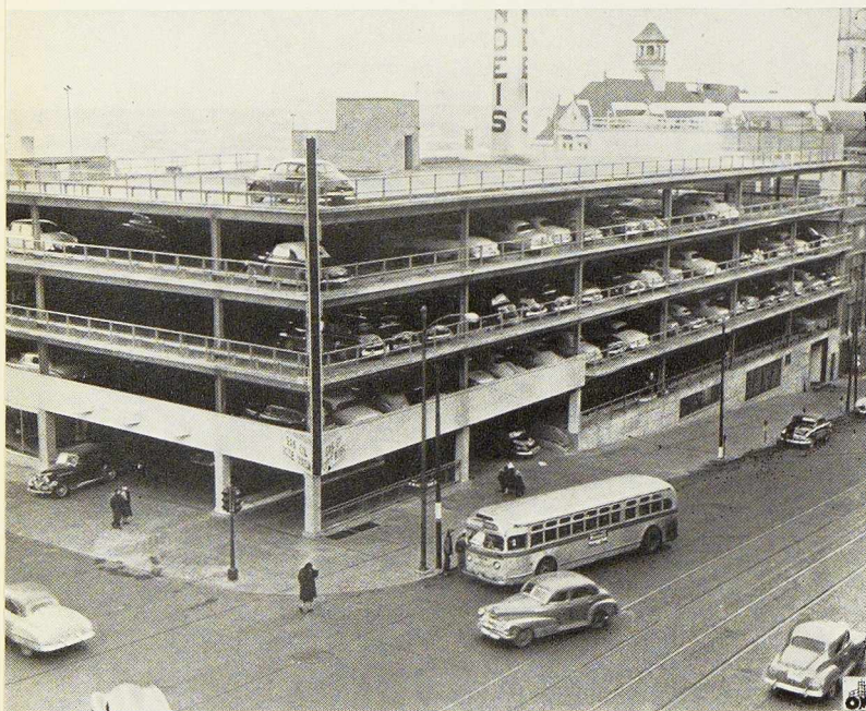
Fig. 2. Garage-parking de la 18 e rue à Omaha (Nébraska). Architecte : Noel S. Wallace. Ingénieur-Conseil : Fred. W. Rice.
