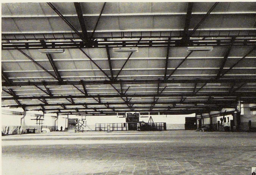
Fig. 8. Vue intérieure du garage. Noter l'absence de tout poteau gênant la manœuvre des voitures.
