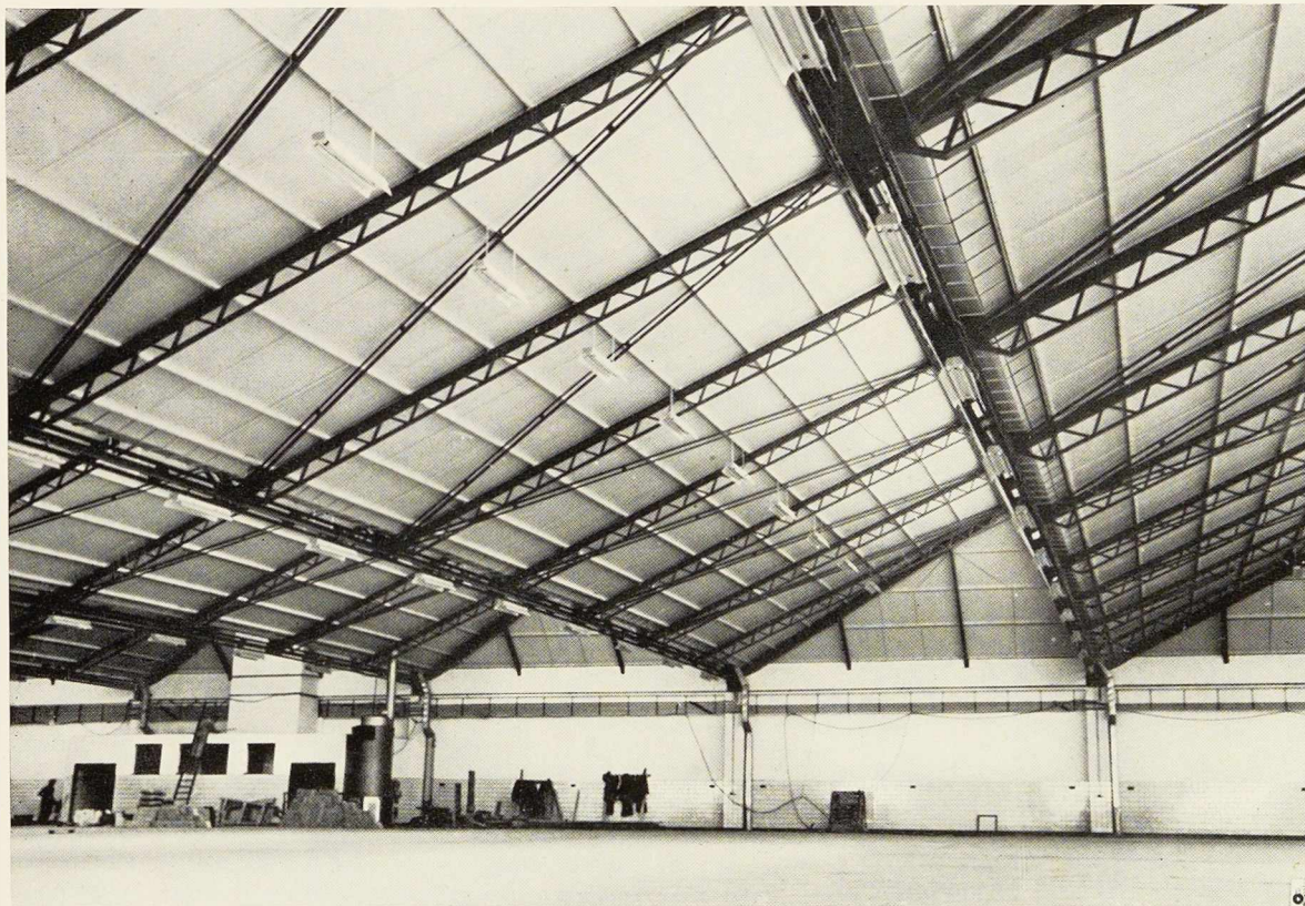
Fig. 2. Vue intérieure du nouveau garage des Anciens Etablissements D'Ieteren Frères à Bruxelles. Noter la légèreté des fermes supportant la toiture.
