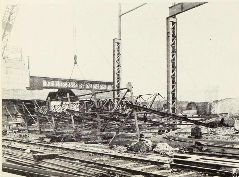
Fig. 6. Montage d'une ferme (prise à terre).
