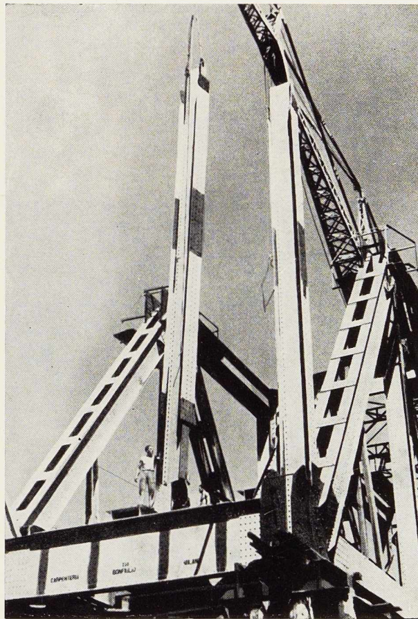
Fig. 5. Montage de la partie supérieure des maîtresses-poutres.
