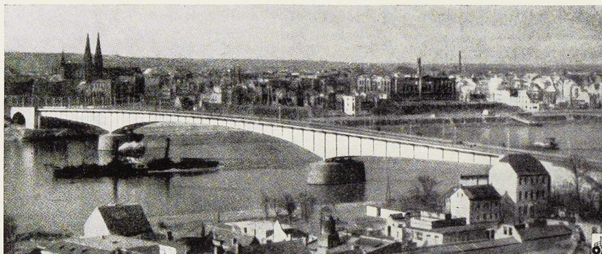
Fig. 3. Pont-route à âme pleine sur le Rhin, à Bonn.
