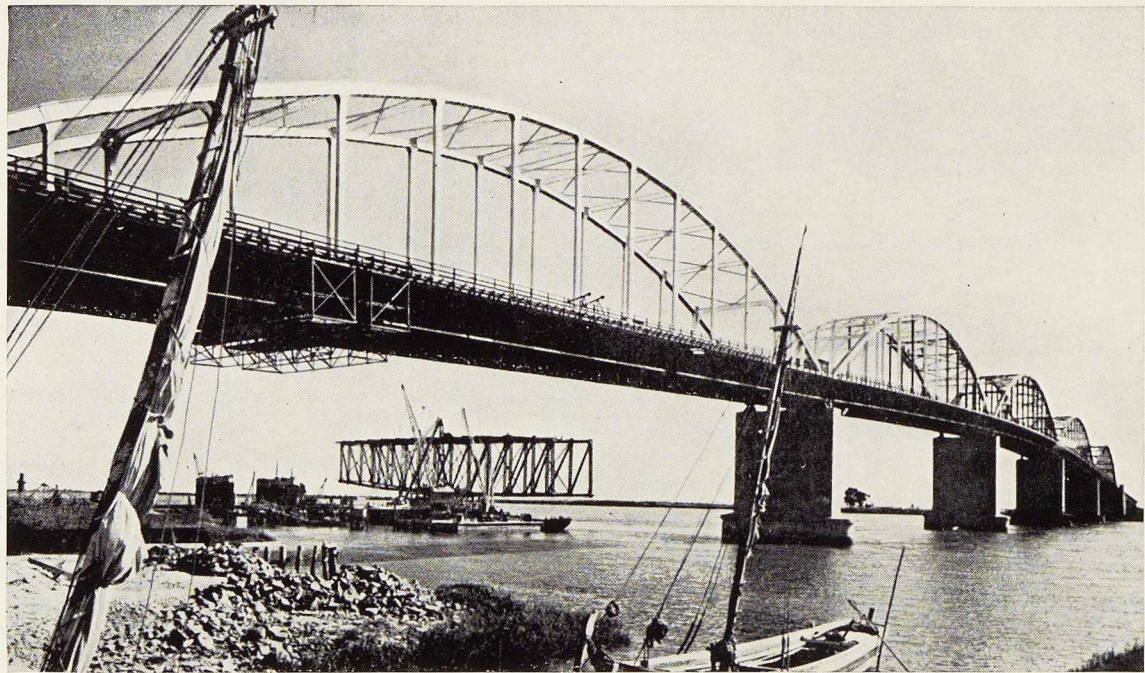
Vue du pont métallique sur le Tage à Vila Franca de Xira (près de Lisbonne), inauguré par le Président de la République portugaise en décembre 1951. L'ouvrage a une longueur totale de 1 224 mètres, dont 524 mètres pour les travées franchissant le fleuve.
