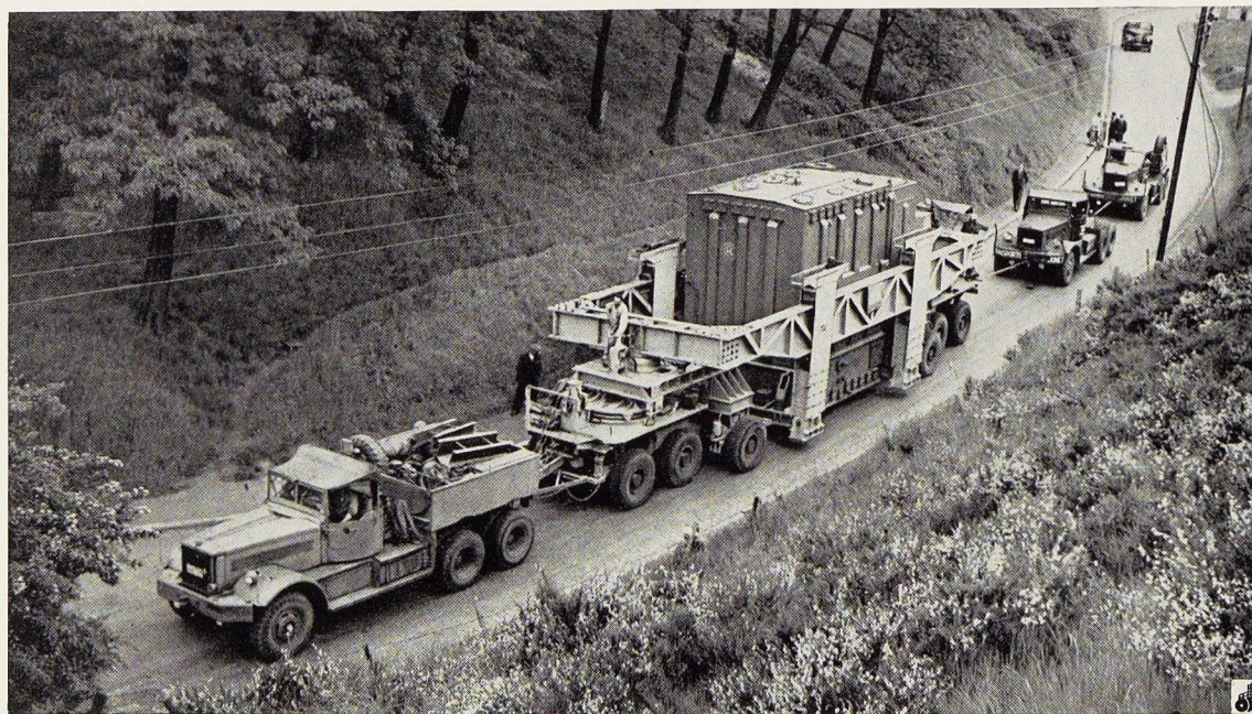
Transformateur 150 000 - 70 000 V A. C. E. C., poids 120 tonnes. Ensemble porteur avec charge 175 tonnes (Voir l'article page 81 de cette revue)
