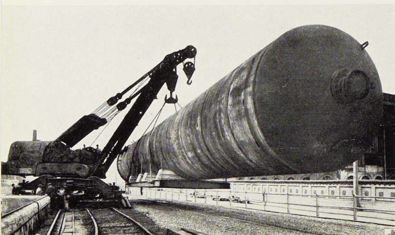
Fig. 8. Manutention d'une tour de 30 mètres de longueur, munie d'un châssis-palette, en vue de sa mise à bord d'un bateau.
