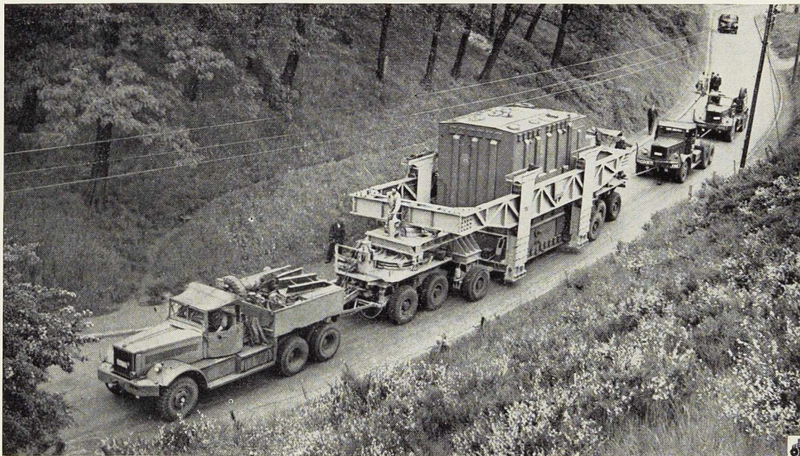
Fig. 1. Transport d'un transformateur de 120 tonnes vers la Centrale des Awirs. Descente de Mons-Crotteux sur Flémalle.
