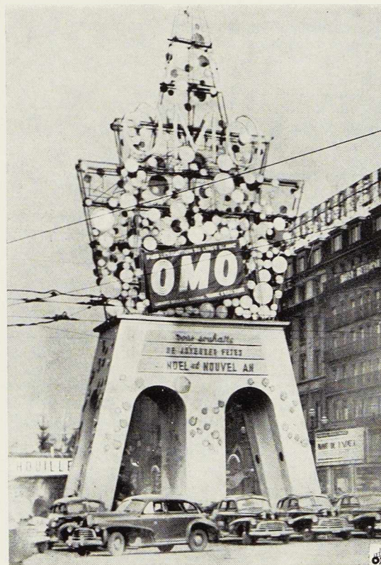
Fig. 2. Tour publicitaire, réalisée en éléments tubulaires par la S. A. Travhydro.
