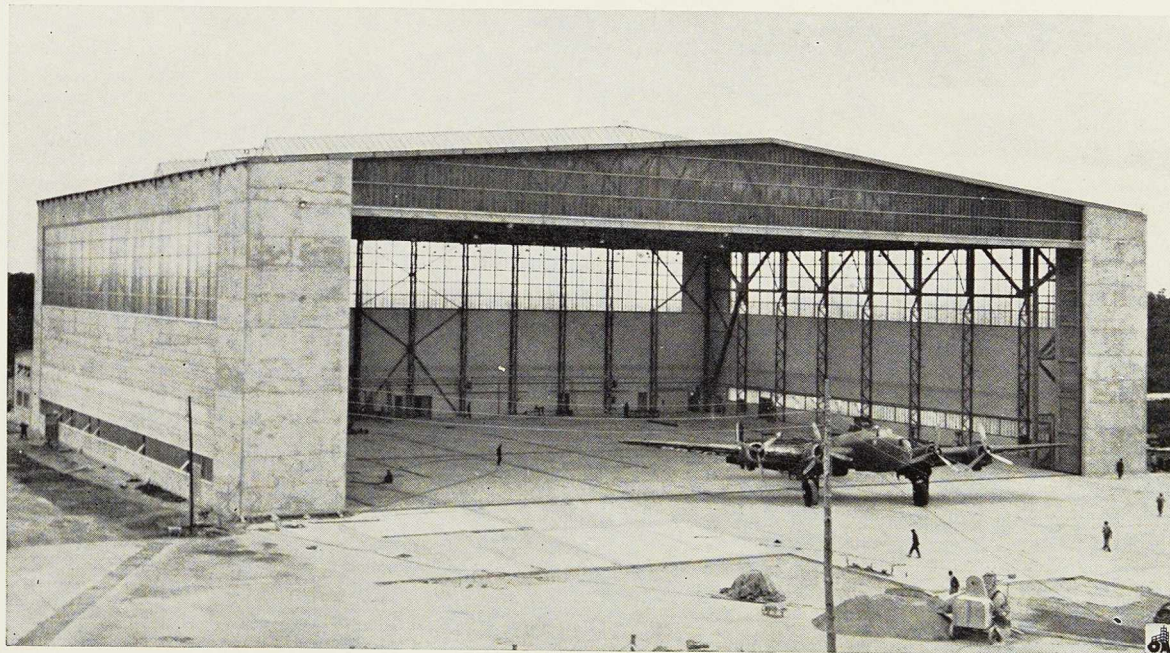
Fig. 1. Vue générale du hangar d'aviation.
