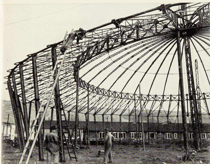
Fig. 8. Charpente métallique en cours de montage.
