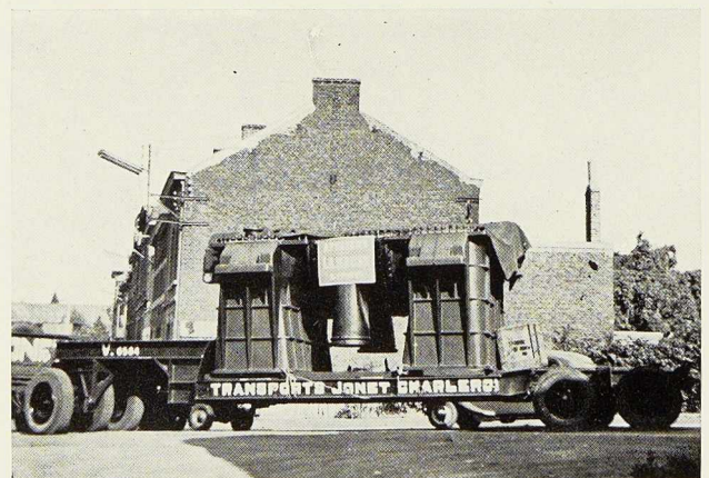
Pièce de condenseur sur remorque de 60 tonnes
