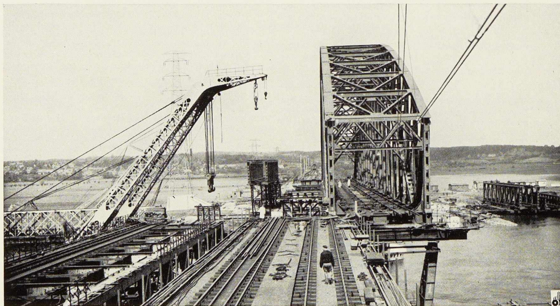
Reconstruction du pont-rails sur le Rhin inférieur à Arnhem (Pays-Bas). L'ouvrage, détruit deux fois au cours de la deuxième guerre mondiale a été récemment remis en service.
