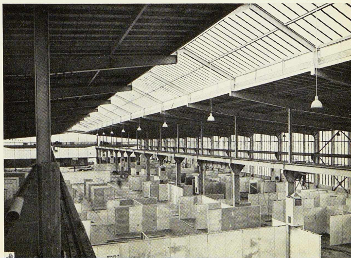
Fig. 3 (ci-dessous). Intérieur du hall n° 8 à la Foire de Hanovre. La surface vitrée dépasse 50 % de la surface bâtie.
