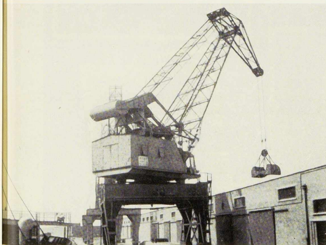
Travail en cours d'exécution au Port de Zeebrugge. Les peintures Bessemer sont employées. La finition sera en aluminium.
