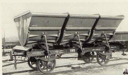
Fig. 4. Wagon-tombereau allemand d'une capacité de 3 \times 5 \text{ m}^3 .
