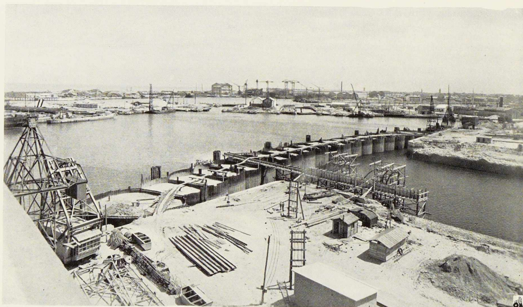
Fig. 8. Batardeau de la darse III à Dunkerque.
