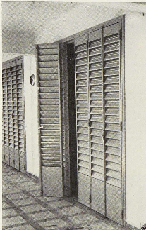
Fig. 5. Porte à persiennage fixe qui laisse passer l'air, tout en diminuant le jour, à Dakar (Afrique).
