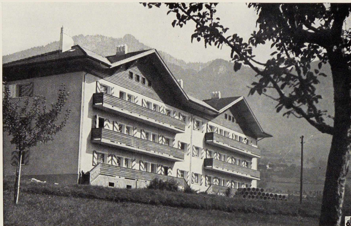
Fig. 3. Série de huit immeubles de douze logements exécutés en Savoie (France). Vue d'un immeuble terminé.
