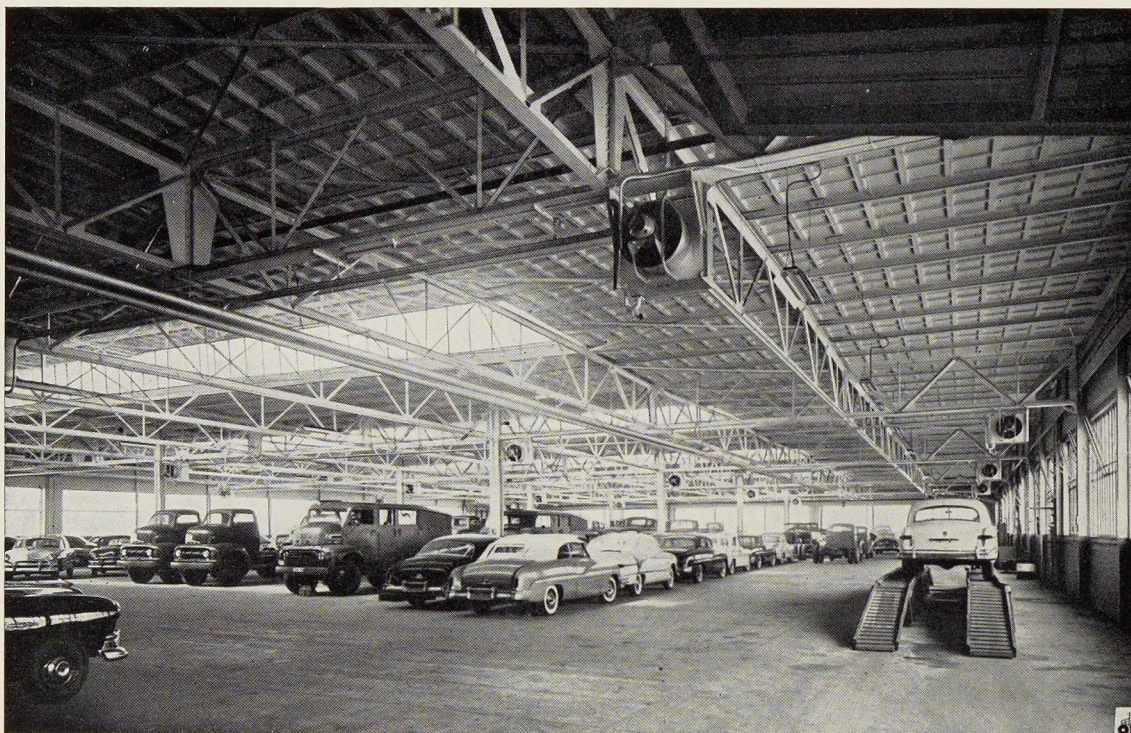
Fig. 6. Vue intérieure du bâtiment destiné au garage des voitures terminées.
