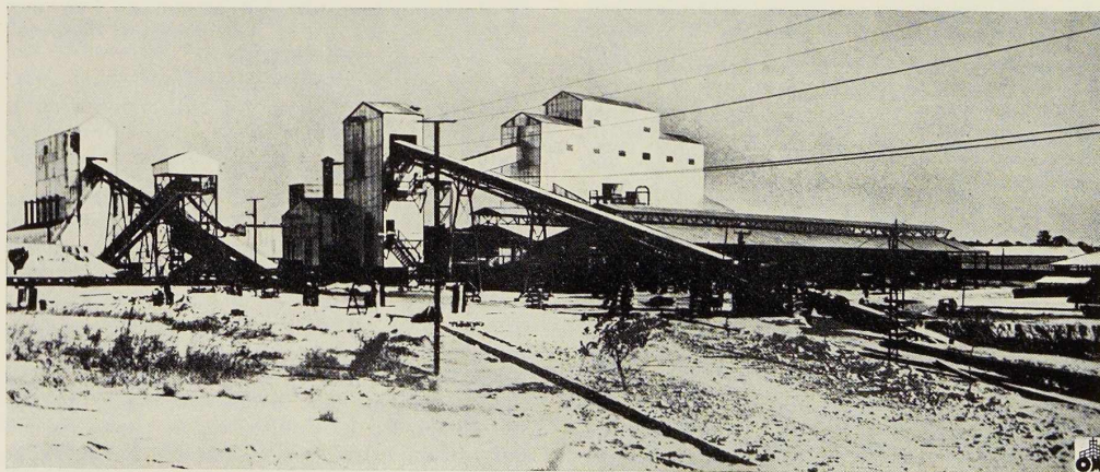
Fig. 1. Ensemble de la nouvelle usine de préparation et concentration au Siège ID15 de la Société Géomines.
