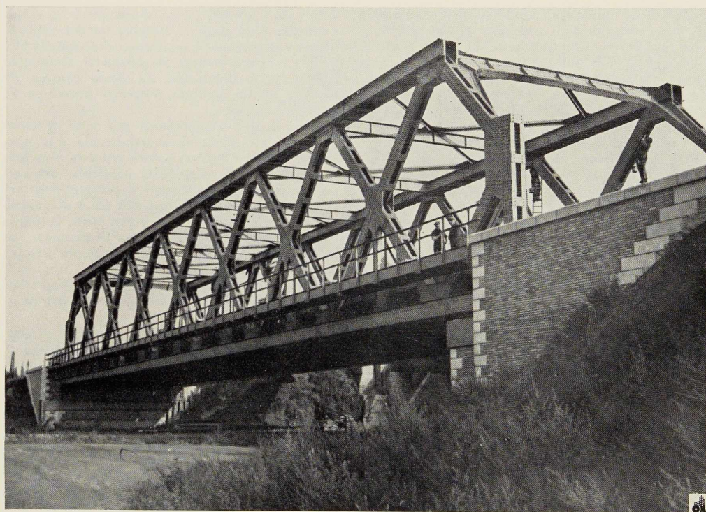
Fig. 5. Vue générale du pont de Nimy-Maisières. L'ouvrage, d'une longueur de 60 mètres, porte deux voies de chemin de fer.
