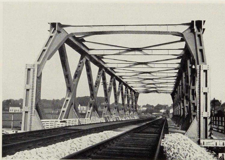
Fig. 8. Vue d'enfilade montrant le contreventement supérieur.
