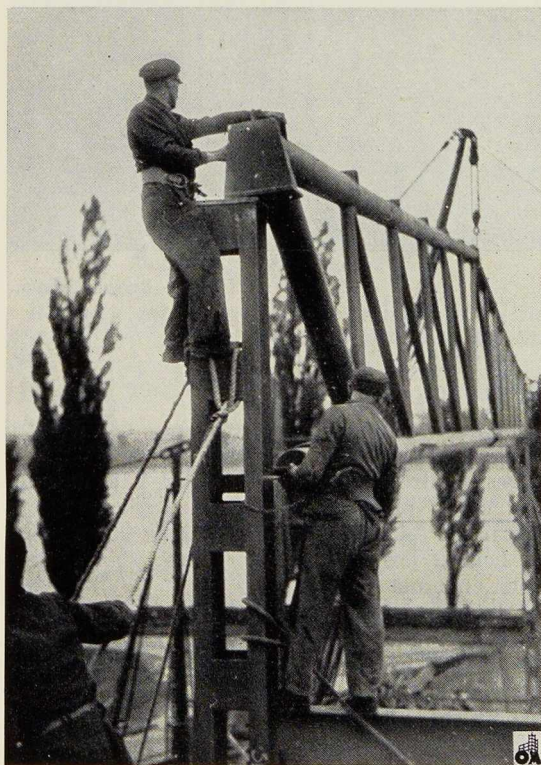
Fig. 7 (ci-dessus). Montage d'une ferme en tubes d'acier.
