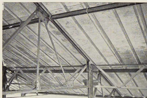
Fig. 6. Charpente de toiture d'un bungalow type BW 4.
