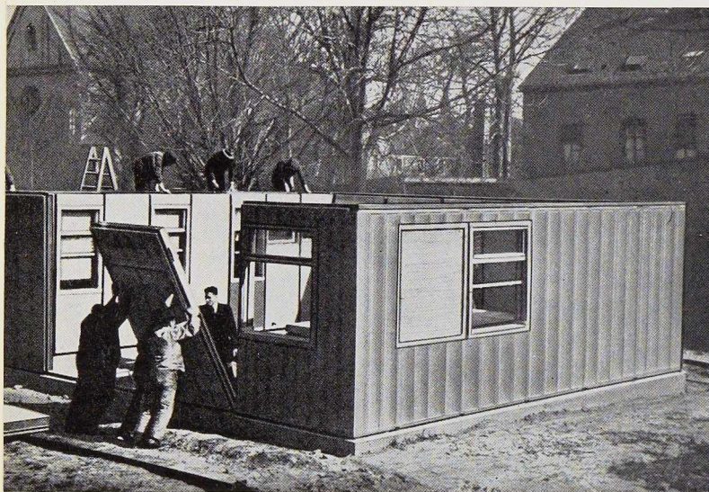
Fig. 5 à 7 (de haut en bas). Montage de la maison M. A. N. Grenier-séchoir. Vue partielle de la cuisine « tout en ordre ».
