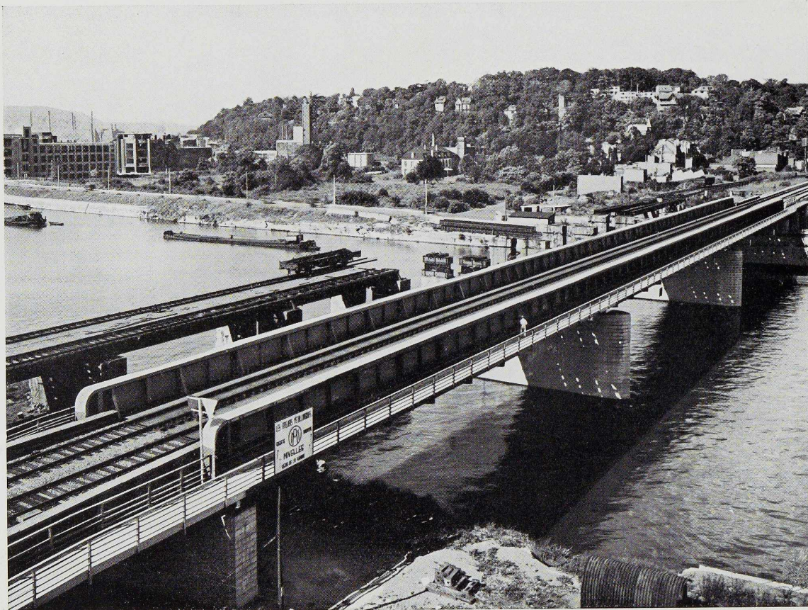
Pont-rail du Val-Benoît à double voie - 212 mètres - 1 859 tonnes.
