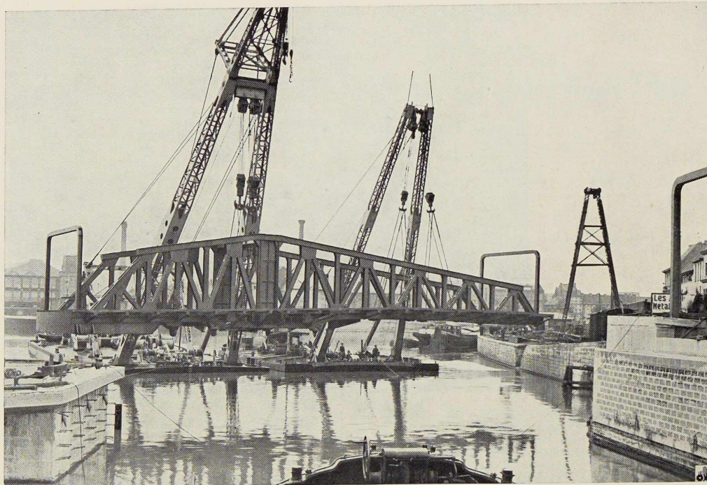
Photo Joseph Buyens. Fig. 7. Une des dernières phases du montage du pont tournant du Muide.
