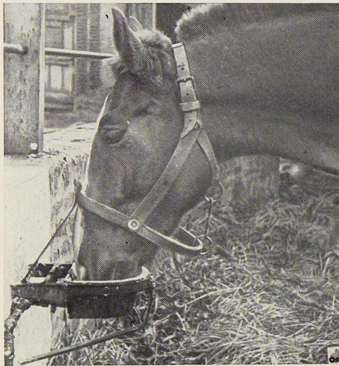
Fig. 3. Abreuvoir automatique : le museau de l'animal en pesant sur la palette ouvre le robinet d'arrivée d'eau.
