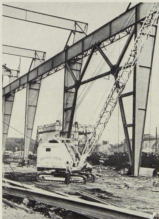
Fig. 1. Sollac. Charpente de l'atelier de concassage de fonte.
