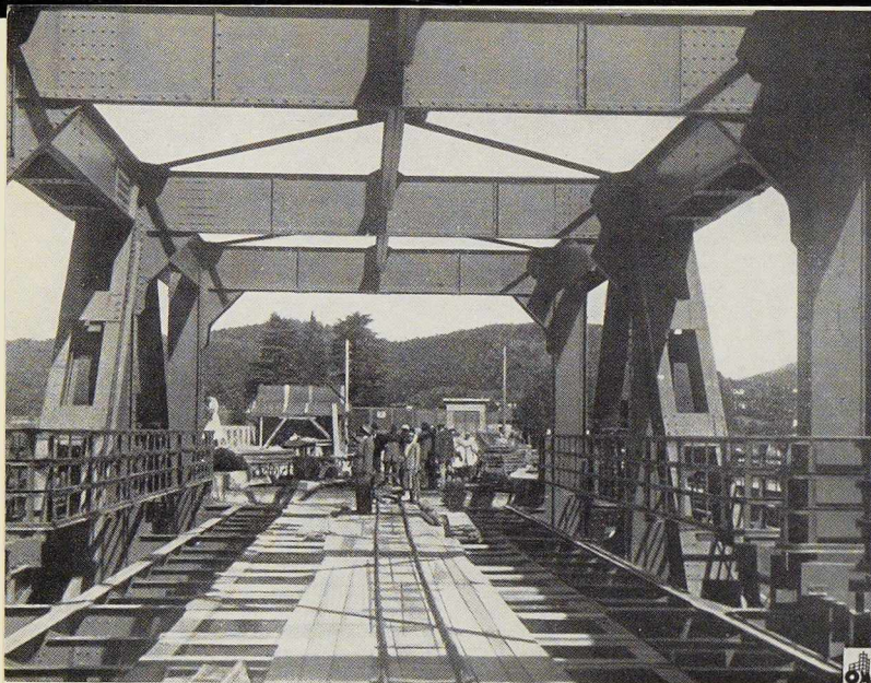
Fig. 1. Vue d'enfilade du nouveau pont métallique sur le Tessin à Sesto Calende.
