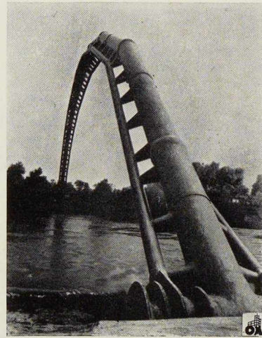
Fig. 1. Pont de canalisations à gaz. Portée 60 mètres.
