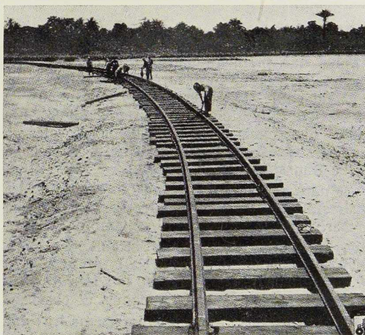
Fig. 2. Construction du chemin de fer reliant le port de Monrovia à Bomi Hills (Liberia).
