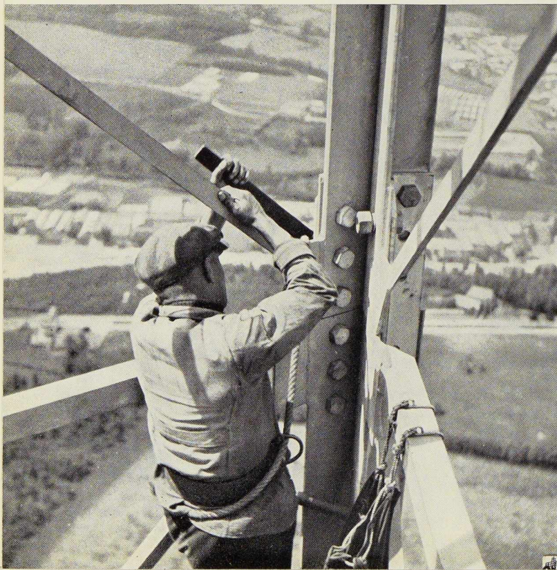
Fig. 4. Serrage des boulons des joints des membrures.
