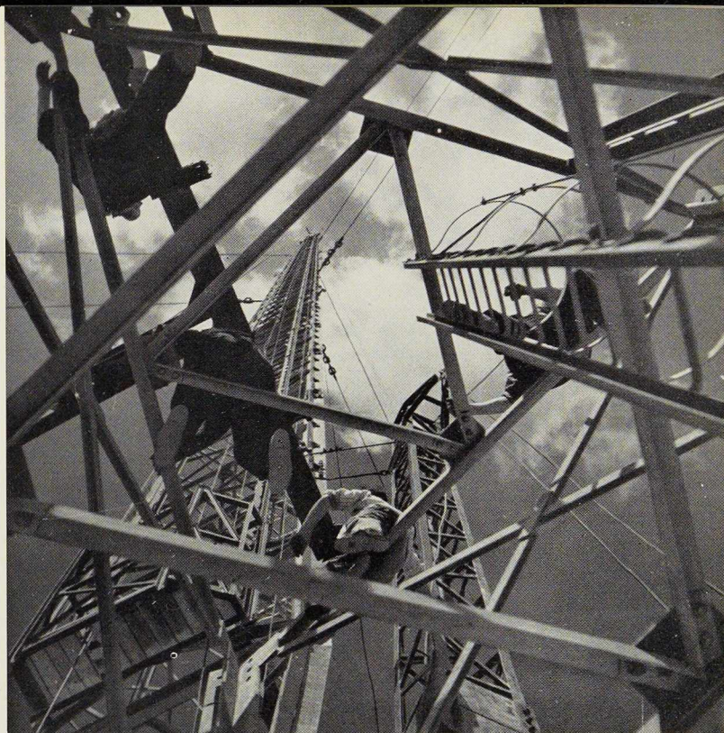
Fig. 5. Opérations préparatoires au hissage d'un tronçon : mise en place du palonnier sur un tronçon placé debout à côté du pylône.
