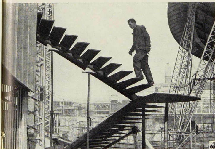
Fig 4. Escalier métallique d'une conception originale au pavillon « La Mer et la Navigation » à Londres. Photo Central Press.
