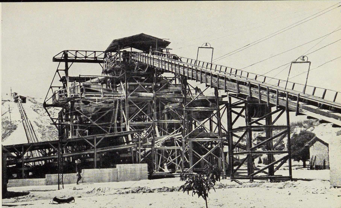
Fig. 35. Ensemble d'une laverie de graviers stannifères de la Société Géomines au Congo belge.
