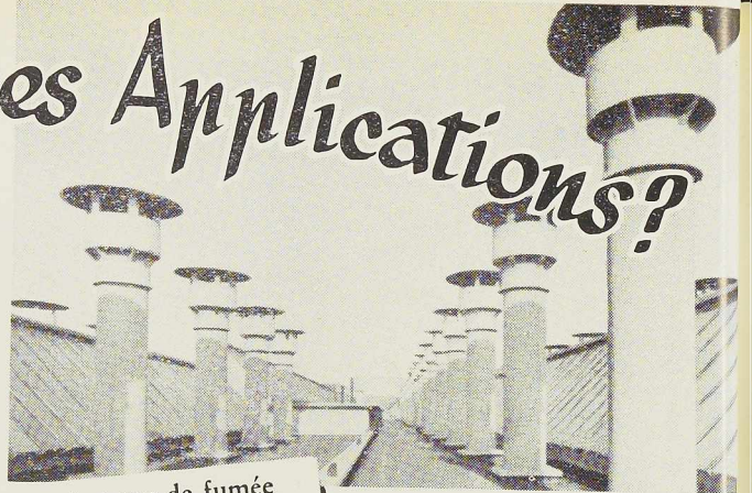
Aspirateurs de fumée Éternit Dépôt de locomotives à Monceau
