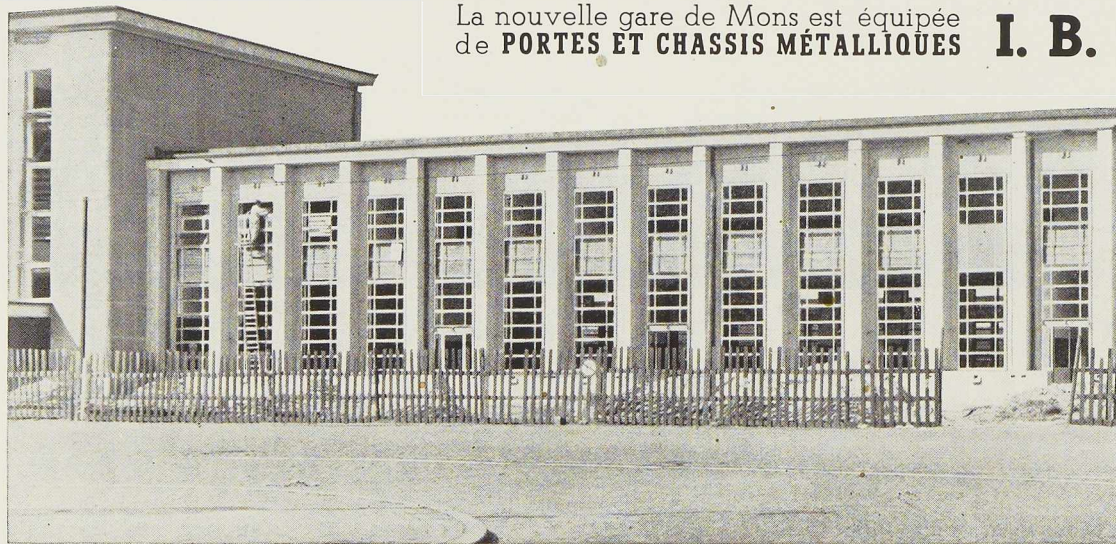
Vue partielle de la façade principale de la gare de Mons. Architecte : R. Panis - Parachèvement : Entreprises Générales L. Leturcq, Tournai.
