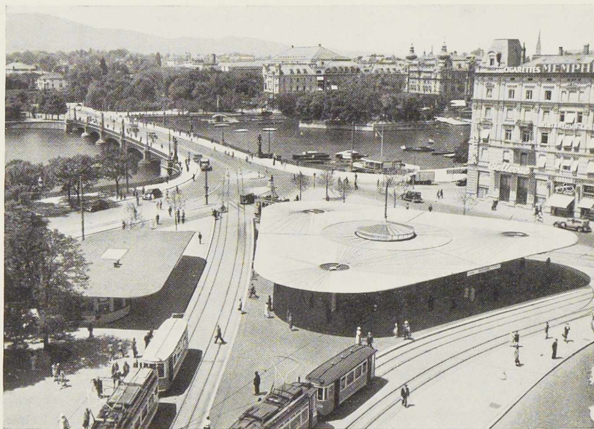
Fig. 68. Vue générale de la Place Bellevue à Zurich (Suisse). L'emploi de l'acier dans la charpente du grand auvent a permis de réaliser une construction légère, aux lignes harmonieuses et d'aspect moderne.
