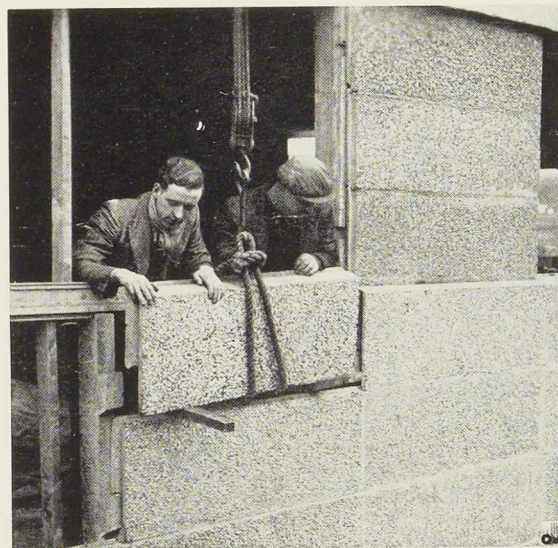
Fig. 34. Cité « Quarry Hills » à Leeds (Angleterre). Posé en façade des blocs en béton vibré coulés à l'avance.
